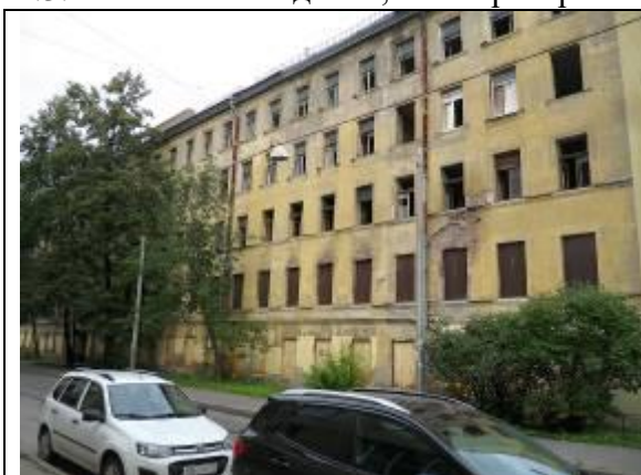
Фото здания со стороны ул. Коли Томчака
