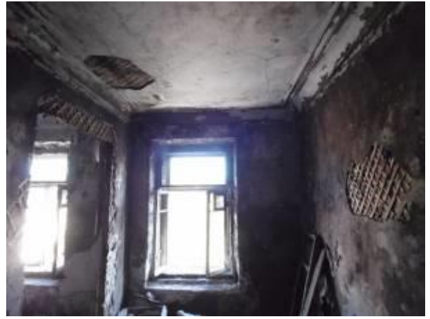
Фото 92 Общий вид комнаты
