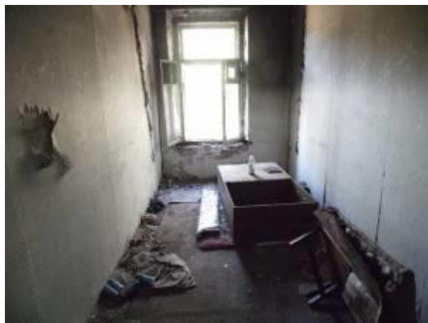
Фото 78 Состояние помещений (комната)
