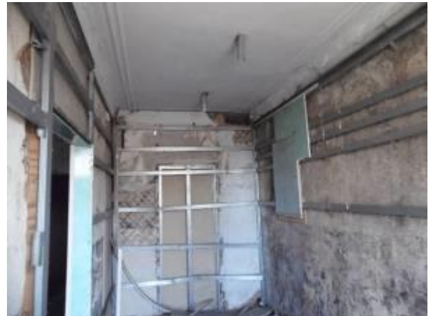
Фото 94 Общий вид кухни
