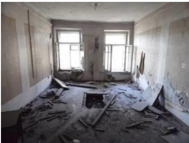
Фото 95 Общий вид комнаты
