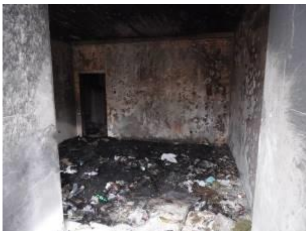
Фото 71 Общий вид помещений
