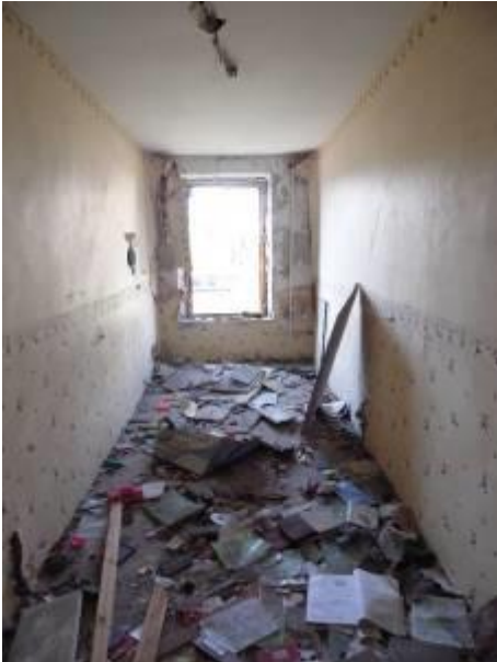
Фото 93 Общий вид комнаты
