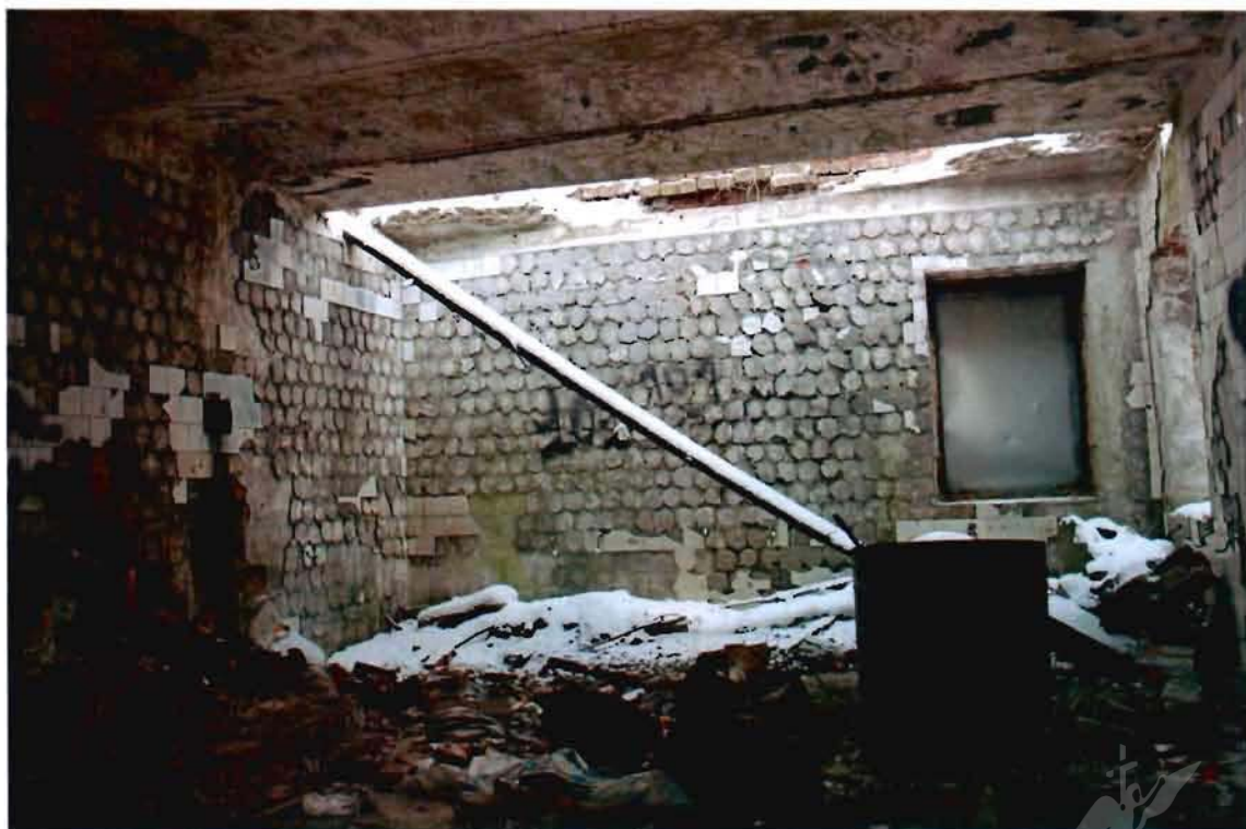
Фото №19. Помещение Н-2.
