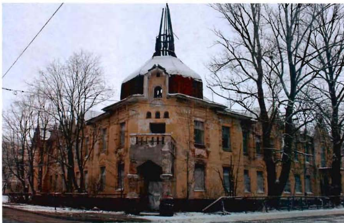
Фото №1. Лицевые фасады со срезанной угловой частью главного входа. Вид со стороны пересечения ул. Пролетарской и Лазаревского пер.
