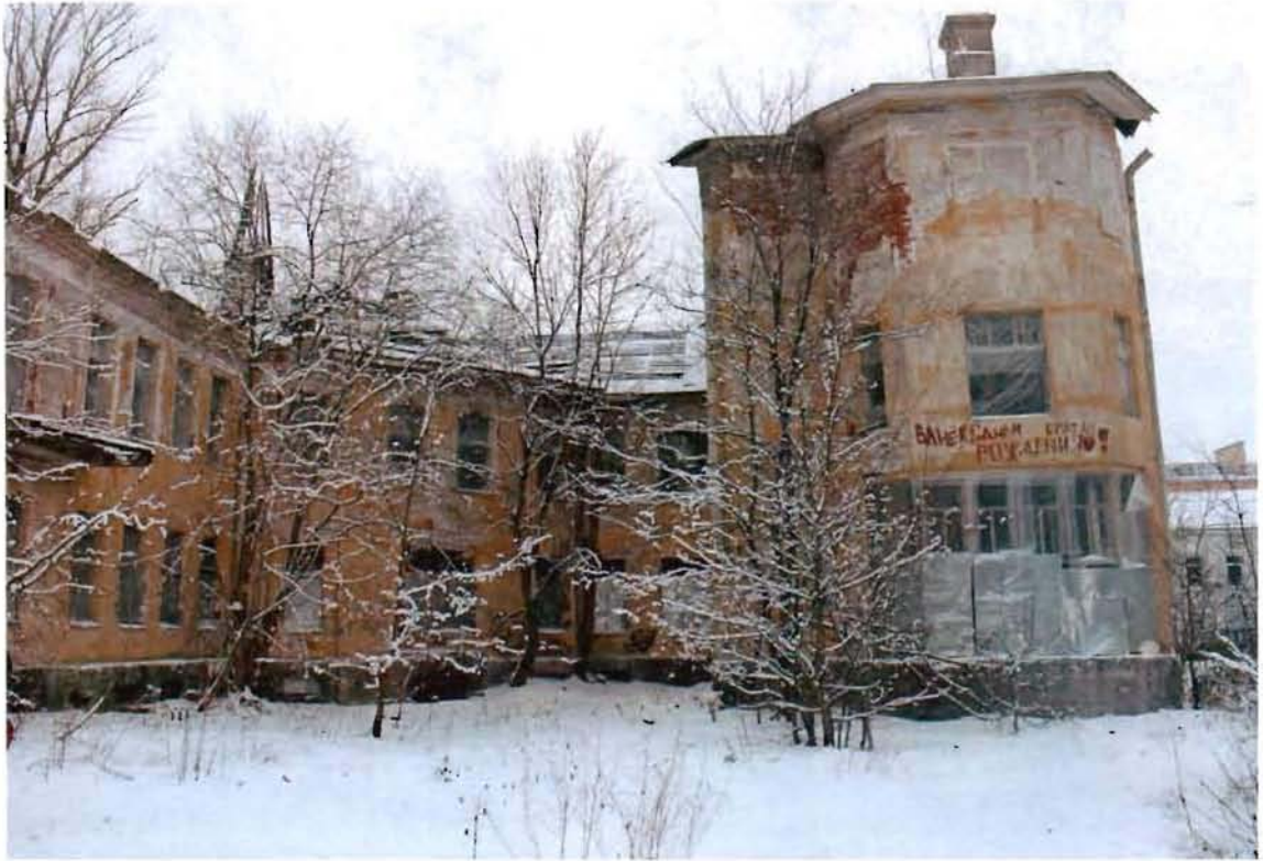
Фото №7. Северный ризалит дворового (восточного) фасада. Вид со стороны Сада.
