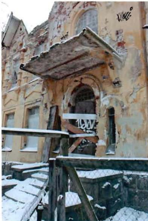
Фото №8, 9. Гранитные крыльца с двухступенчатым парапетом.
