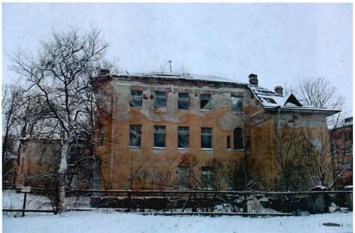
Фото №4. Вид на торцевой (северный) фасад со стороны двора.
