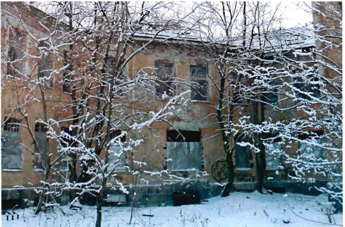
Фото №6. Фрагмент дворового (восточного) фасада с прямком. Вид со стороны Сада.
