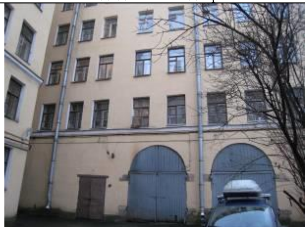
Фото 20 Вид здания 2-го двора
