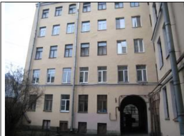
Фото 21 Вид здания 2-го двора
