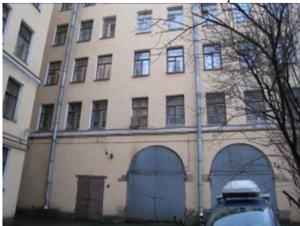
Фото здания со 2-го двора
