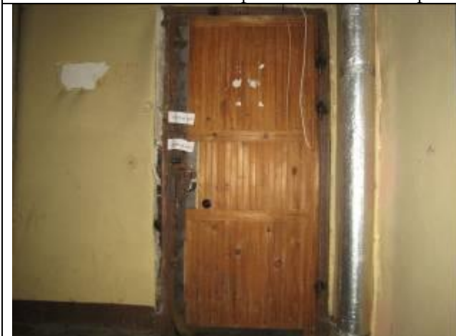
Фото 25 Вид входной двери в кв. №85
