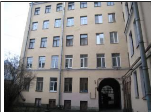
Фото 21 Вид здания 2-го двора
