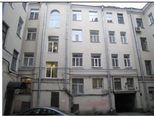
Фото 18 Вид здания 1-го двора
