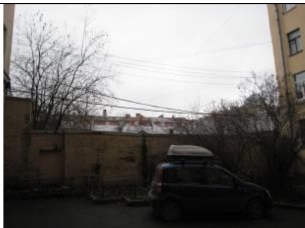
Фото 22 Вид здания 2-го двора
