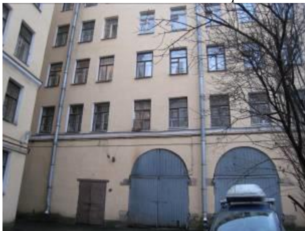
Фото здания со 2-го двора
