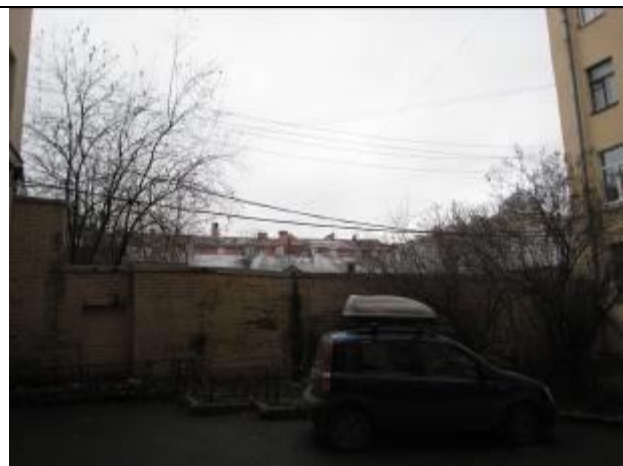
Фото 22 Вид здания 2-го двора
