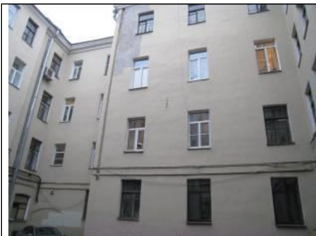
Фото 17 Вид здания 1-го двора
