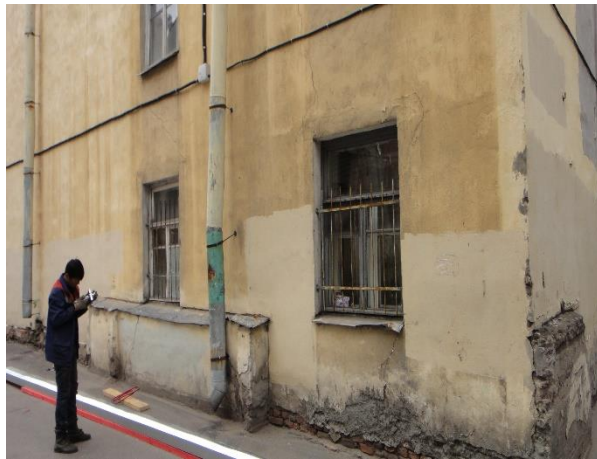
Фото 27 Вид на окна
