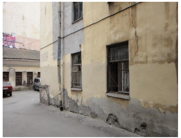
Фото 26 Вид на окна
