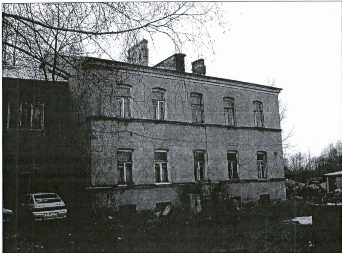
ФОТО № 2. Кирпичная часть дома.
