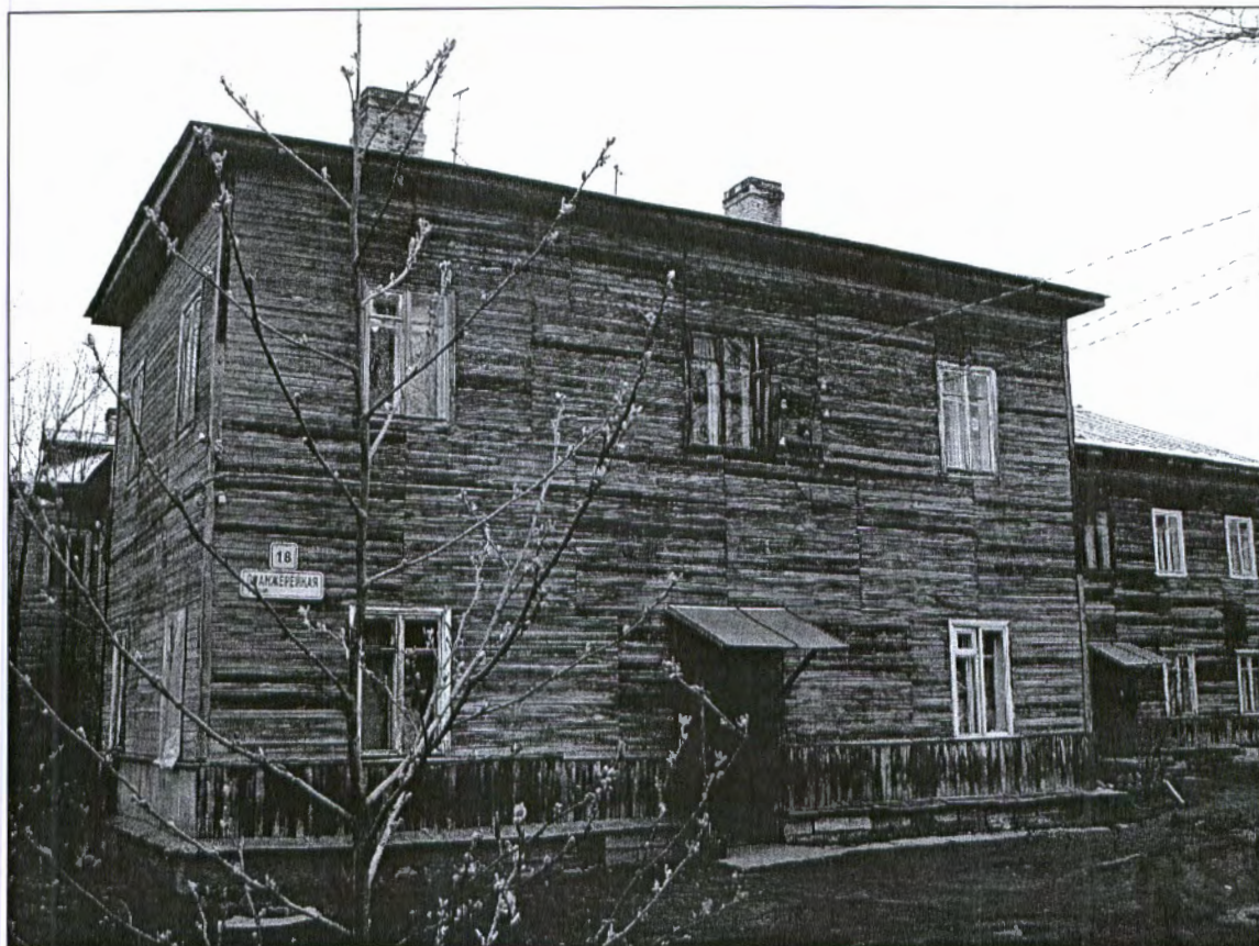
ФОТО № 1. Деревянная часть дома.
