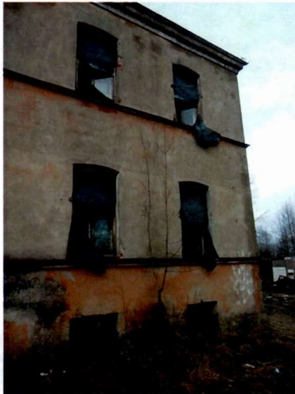
4. Северный флигель. Восточный фасад.
