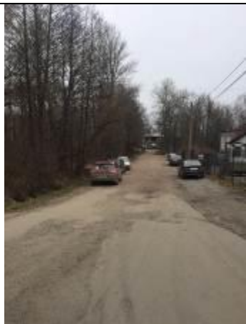
Фото 1. Оранжевая улица. Подъездные пути
