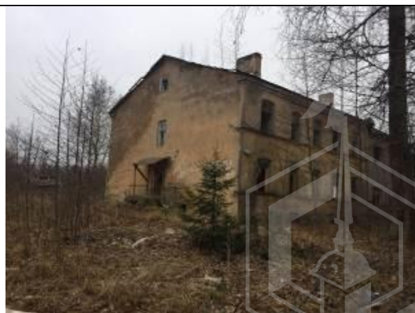
Фото 8. Вид дома (кирпичная кладка)
