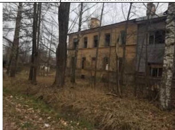
Фото 7. Вид дома (кирпичная кладка)
