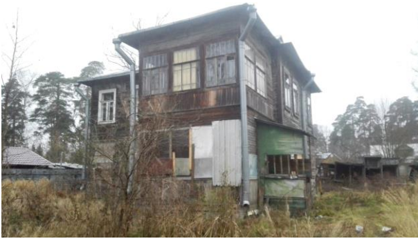
Фото 3. Вид фасада здания.
