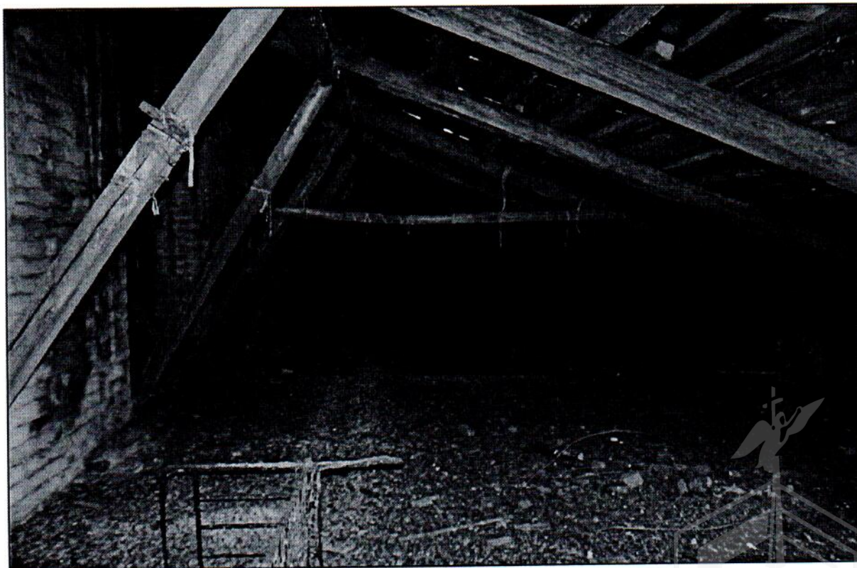
14. Интерьер. Чердак. Стропильная система.
