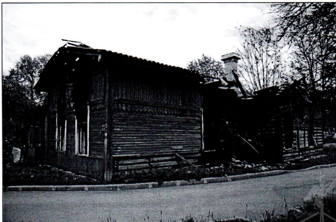
16. Общий вид. Юго-западный фасад.
