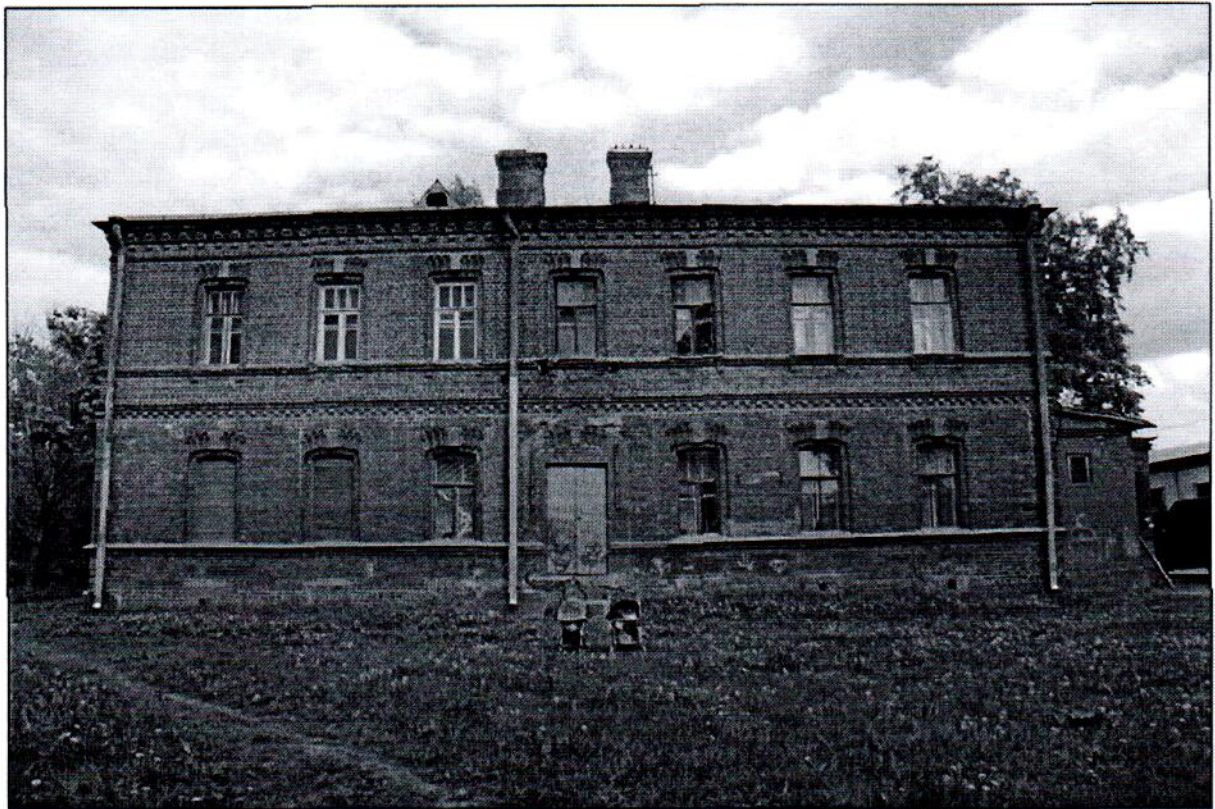
3. Общий вид. Западный фасад
