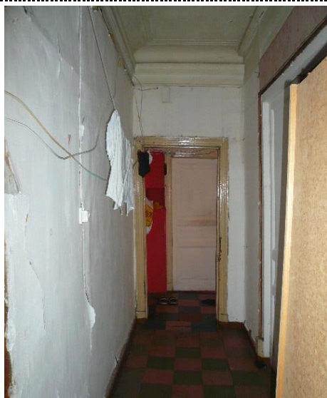
Вид части помещения №16
