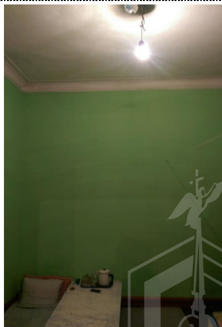
Вид части помещения №9
