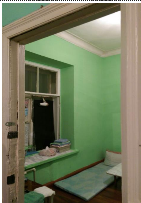
Вид части помещения №9
