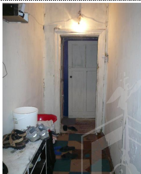
Вид части помещения №16
