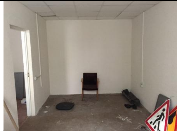
Фото 23: Ч.п. 2. Выявлена самовольная перепланировка: зашит дверной проем, обозначенный на плане
