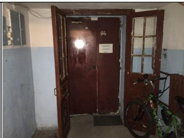
Фото 12: Общее состояние подъезда.
