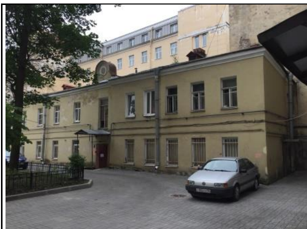
Фото 1: Фасад здания, в котором расположен Объект оценки.
