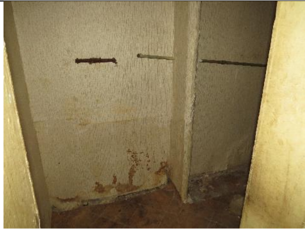
Фото 17. Вид части помещения №№3,4
