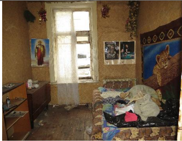
Фото 28. Вид части помещения №5
