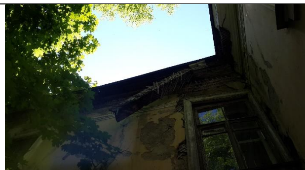
Фото 9. Состояние стен (отпадение штукатурного слоя, сырость, разрешение водоотливных желобов)
