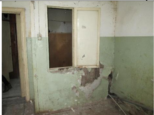
Фото 18. Вид части помещения №4
