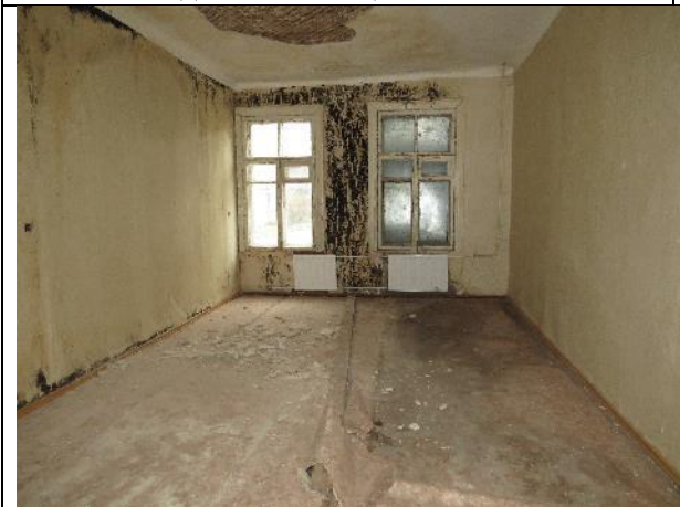
Фото 36. Вид части помещения №5
