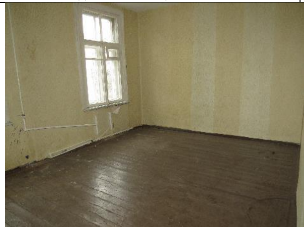
Фото 40. Вид части помещения №6
