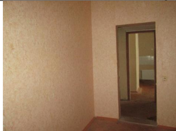
Фото 50. Вид части помещения №1
