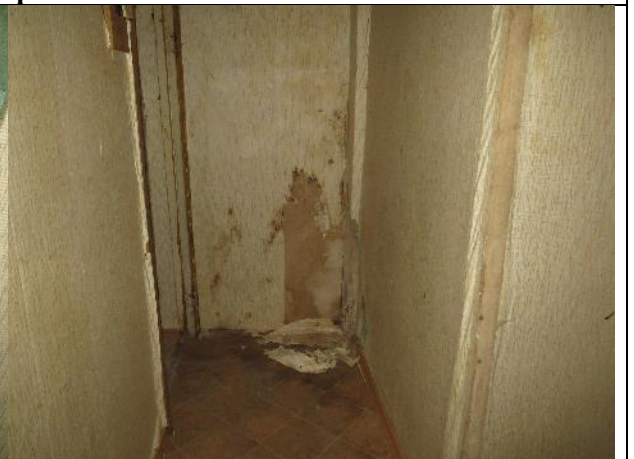
Фото 35. Вид части помещения №6
