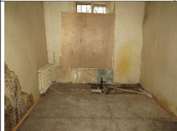
Фото 24. Вид части помещения №3
