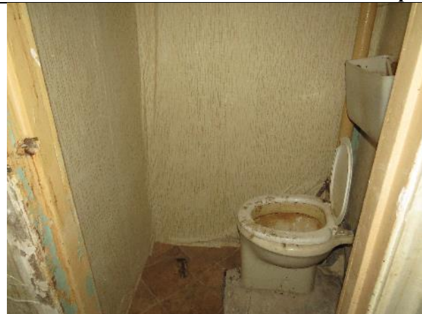
Фото 38. Вид части помещения №2
