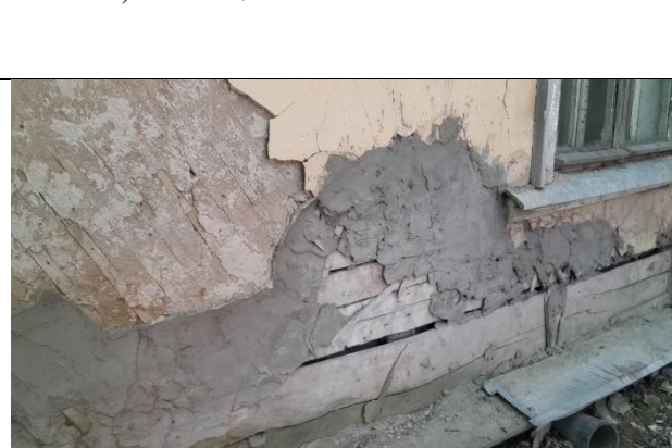
Фото 7. Состояние стен (отпадение штукатурного слоя, сырость)
