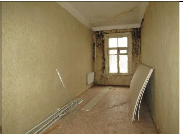
Фото 37. Вид части помещения №4
