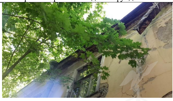
Фото 10. Перекосы стен, выпучивания отдельных бревен, трещины, вызванные неравномерными осадками фундамента
