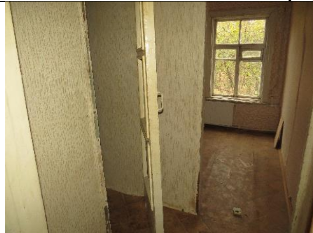
Фото 54. Вид части помещения №1
