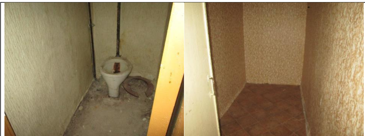
Фото 44. Вид части помещения №№3,4
