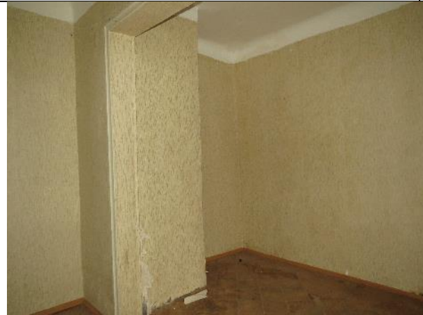
Фото 52. Вид части помещения №5
