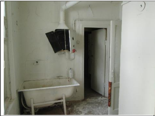
Фото 32. Вид части помещения №5
