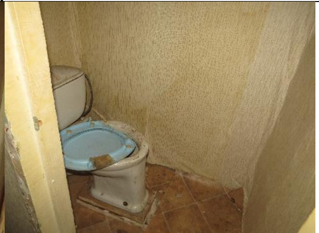
Фото 55. Вид части помещения №2
