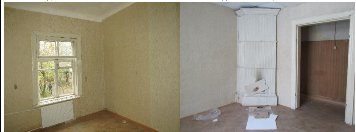
Фото 48. Вид части помещения №4
