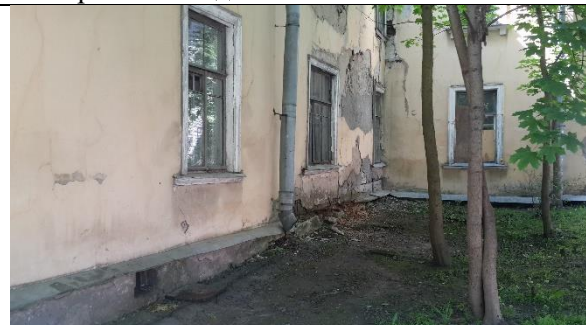
Фото 5. Состояние стен (отпадение штукатурного слоя) стен и цоколя
