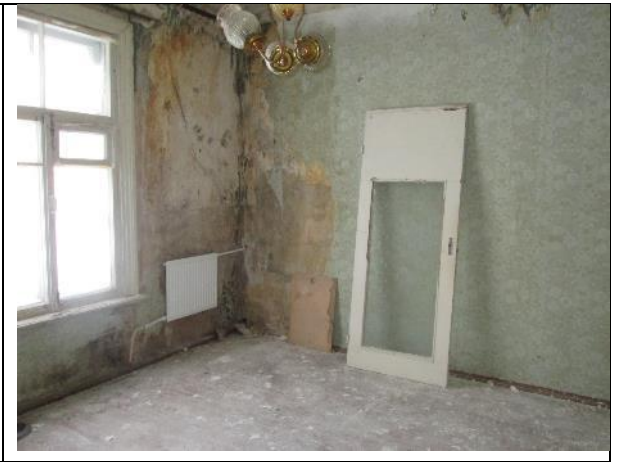
Фото 21. Вид части помещения №3
