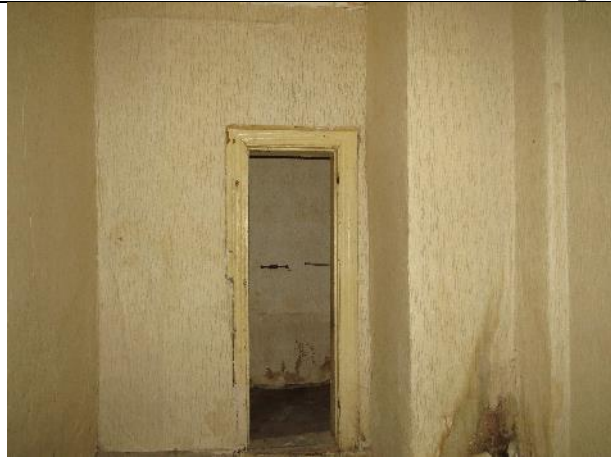
Фото 15. Вид части помещения №1
