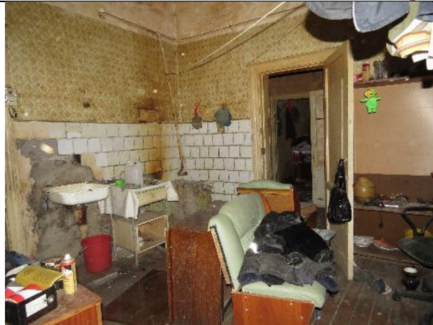
Фото 26. Вид части помещения №1
