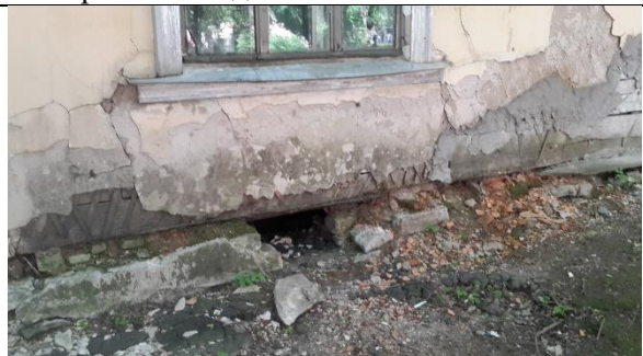
Фото 6. Состояние стен (сырость, отпадение штукатурного слоя) стен и цоколя (разрушение кирпичной кладки, следы увлажнения)
