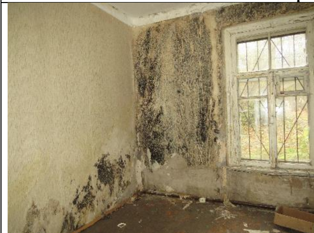
Фото 22. Вид части помещения №6
