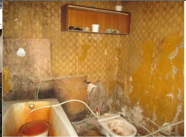
Фото 27. Вид части помещения №№2,3
