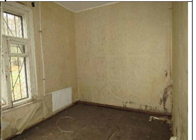
Фото 23. Вид части помещения №4
