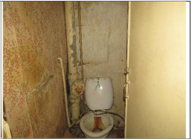
Фото 33. Вид части помещения №2 (санузел)
