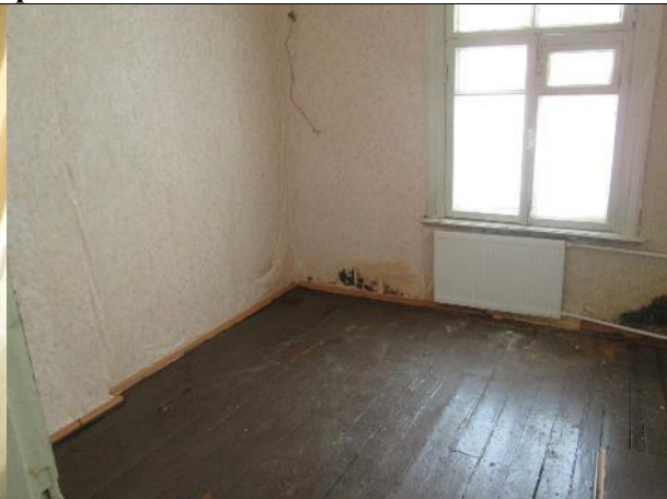
Фото 39. Вид части помещения №5
