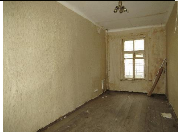
Фото 16. Вид части помещения №2
