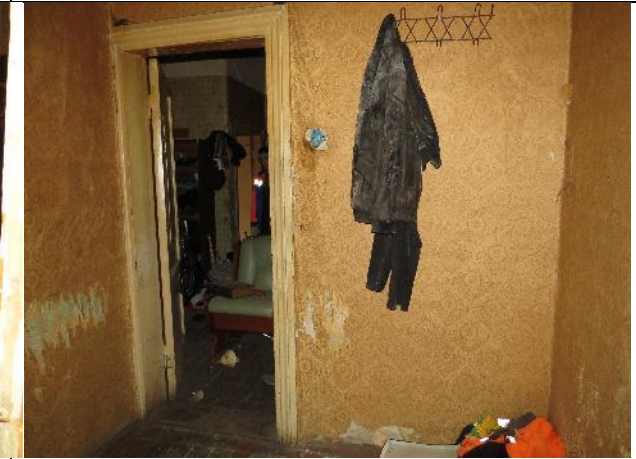
Фото 29. Вид части помещения №4
