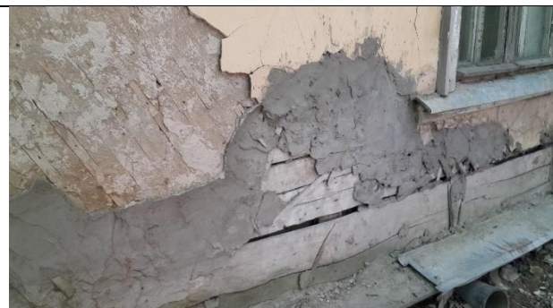
Фото 7. Состояние стен (отпадение штукатурного слоя, сырость)
