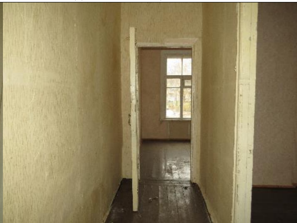
Фото 41. Вид части помещения №4
