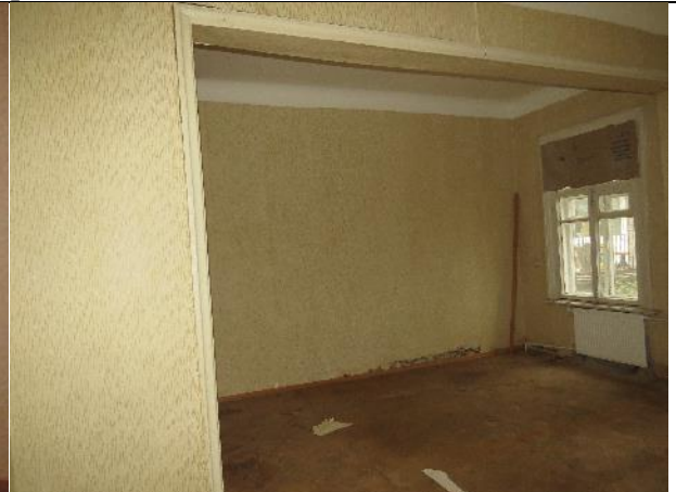
Фото 51. Вид части помещения №5
