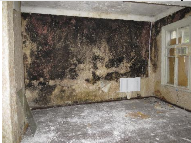
Фото 30. Вид части помещения №4
