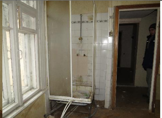
Фото 53. Вид части помещения №4
