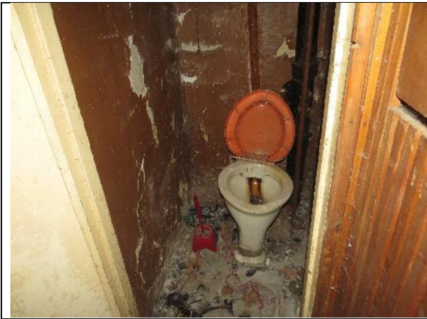
Фото 20. Вид части помещения №7
