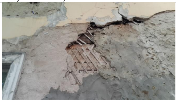
Фото 8. Перекосы стен, выпучивания отдельных бревен, трещины, вызванные неравномерными осадками фундамента
