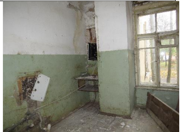
Фото 19. Вид части помещения №4
