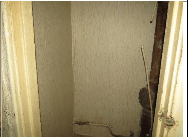
Фото 25. Вид части помещения №2
