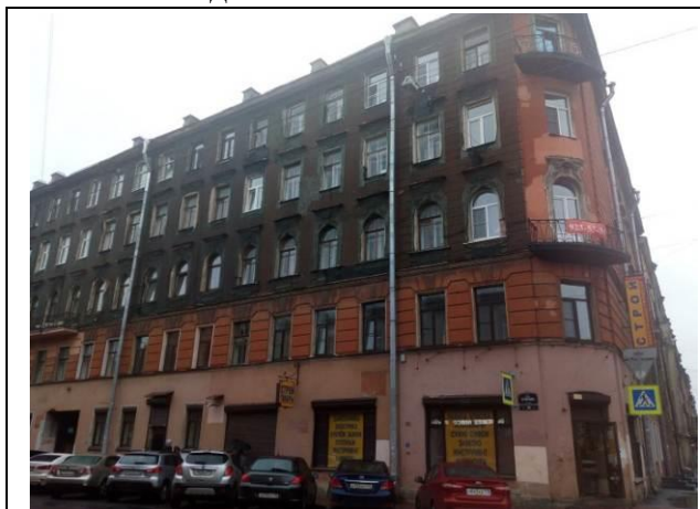
Фото 1. Вид части фасада жилого дома.
