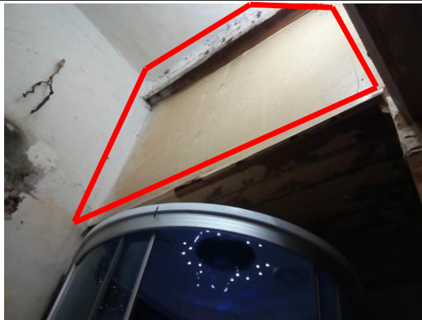
Фото 17. Санузел ч.п. 2.(часть перепланировки)
