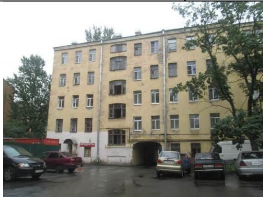
Фото 9. Общий вид дома со двора • состояние помещения
