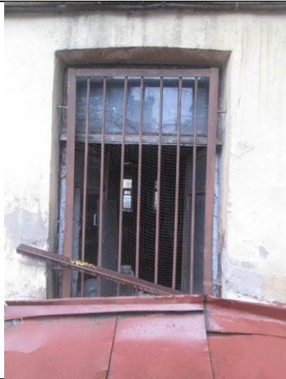
Фото 21. Общий вид окна со стороны двора
