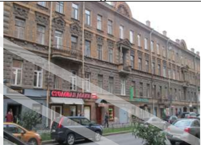
Фото 16. Вид фасада здания
