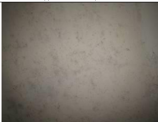
Фото 18 Вид потолка части помещения №1
