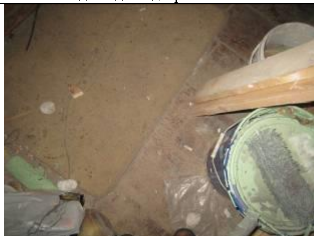
Фото 17 Вид пола части помещения №1
