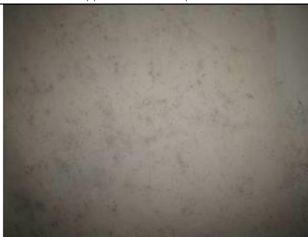
Фото 18 Вид потолка части помещения №1
