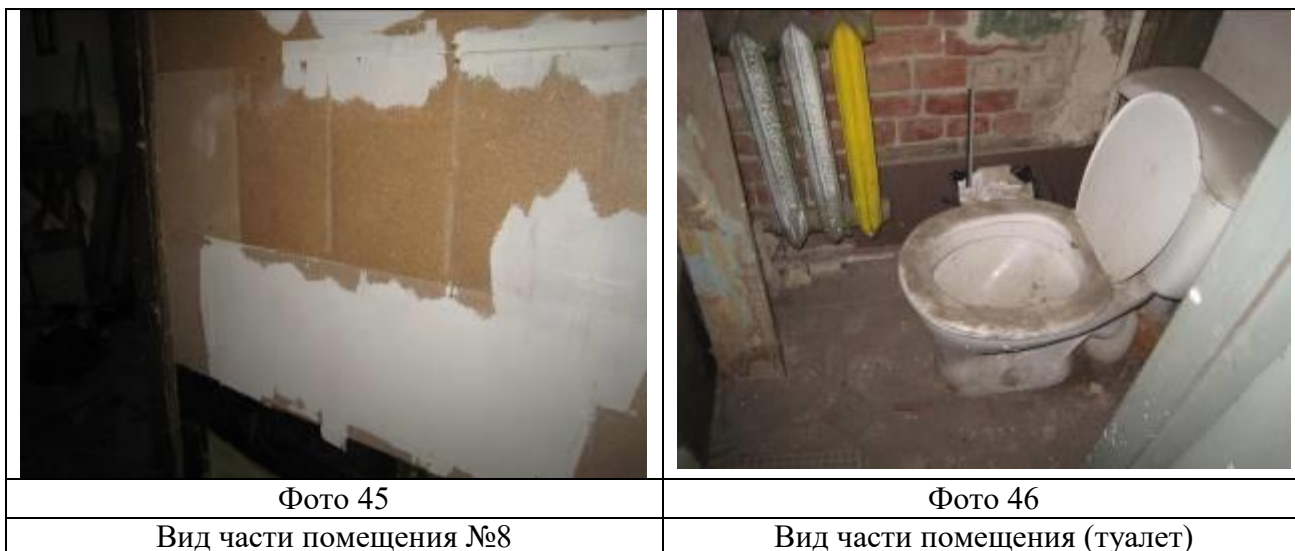
Фото 45 Вид части помещения №8
