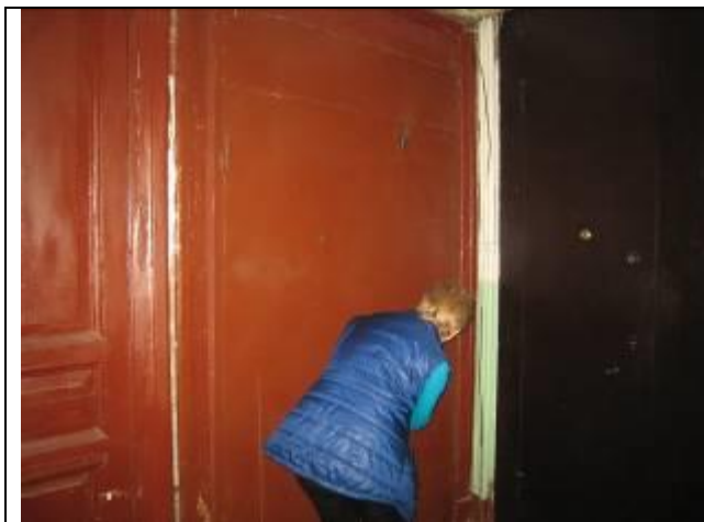
Фото 15 Вид входной двери в кв. №43
