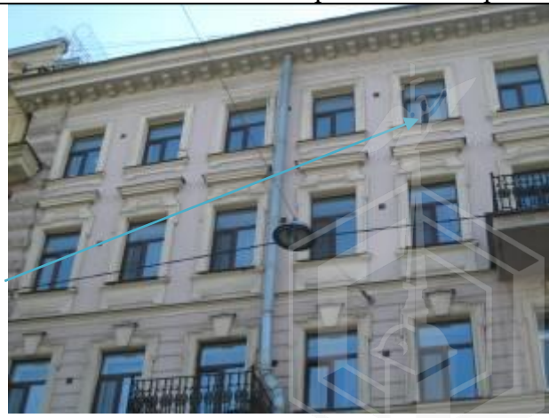
Вид входа с общей парадной со двора
