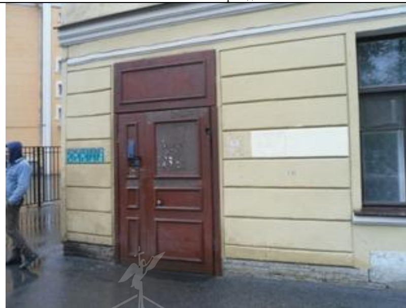
Фото 12 Вид входа в подьезд
