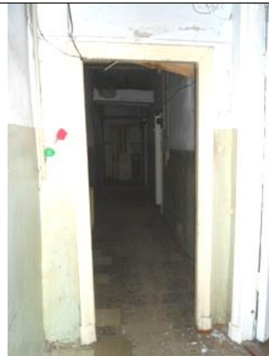
Фото 18 Вид ч.п. 1, вход в ч.п.2
