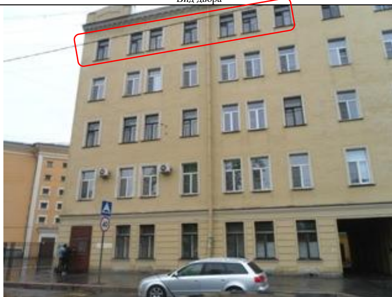
Фото 11 Вид окон объекта оценки
