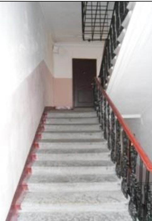
Фото 14 Вид лестничной клетки
