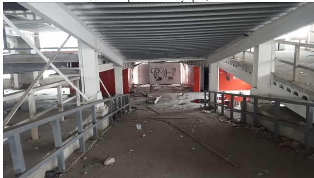
Фото 20 Вид на паркинг изнутри, 1 этаж
