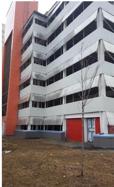
Фото 13 Вход в паркинг с бокового фасада
