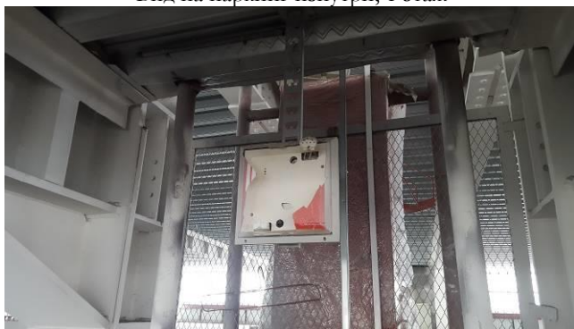
Фото 21 Внутреннее состояние здания
