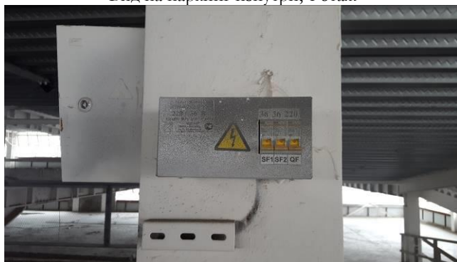
Фото 22 Состояние оборудования здания.
