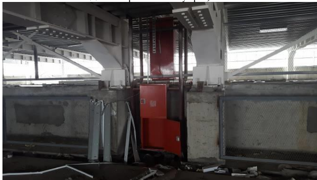
Фото 19 Вид на паркинг изнутри, 1 этаж
