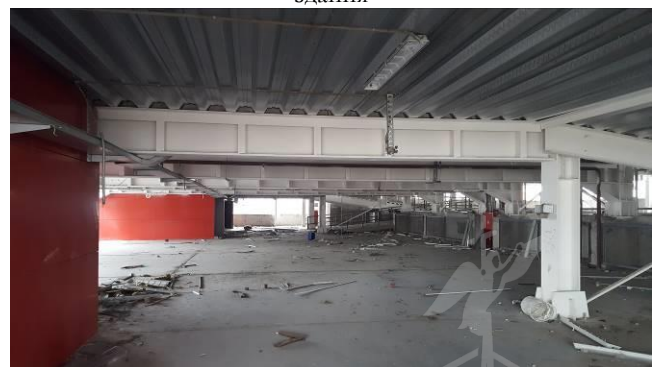
Фото 16 Вид на паркинг изнутри, 1 этаж
