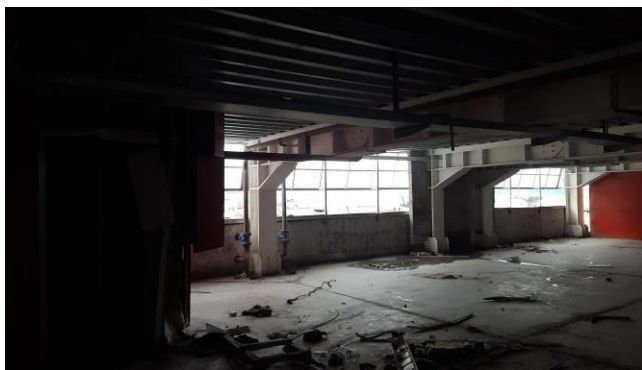
Фото 17 Вид на паркинг изнутри, 1 этаж
