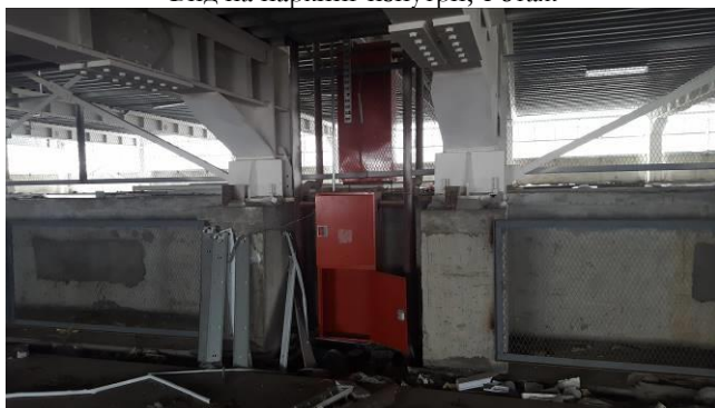
Фото 19 Вид на паркинг изнутри, 1 этаж
