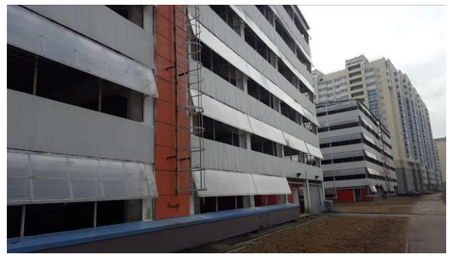
Фото 10 Пожарная лестница на крышу
