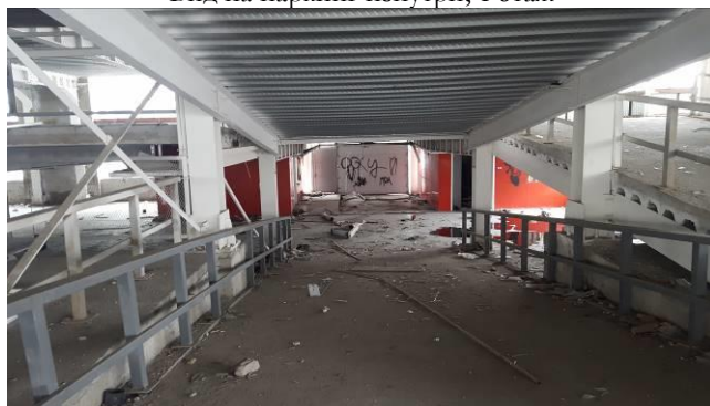
Фото 20 Вид на паркинг изнутри, 1 этаж
