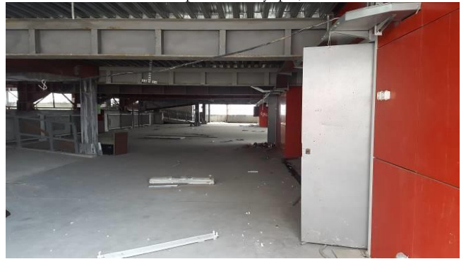
Фото 18 Вид на паркинг изнутри, 1 этаж
