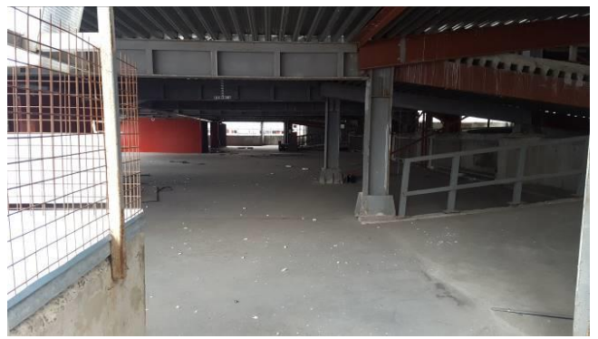
Фото 16 Вид на паркинг изнутри, 1 этаж
