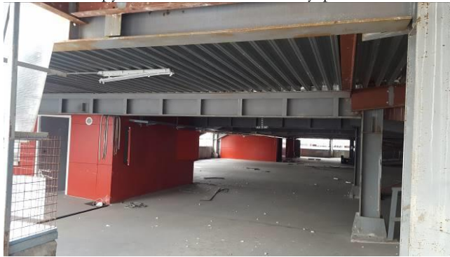
Фото 17 Вид на паркинг изнутри, 1 этаж
