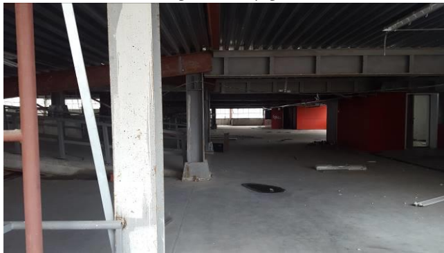
Фото 19 Вид на паркинг изнутри, 1 этаж
