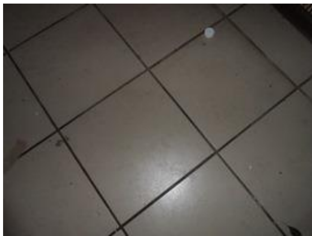
Фото 27. Часть помещения №2,3 помещения 6-Н, напольное покрытие
