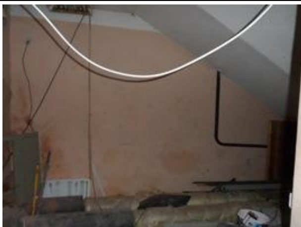
Фото 37. Вход в часть помещения №1 помещения 6-Н с первого этажа
