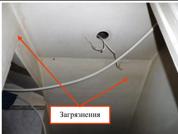
Фото 68. Часть помещения №8 помещения 6-Н, потолок
