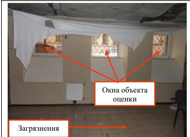
Фото 41. Часть помещения №5-6 помещения 6-Н, вид на окна от входа
