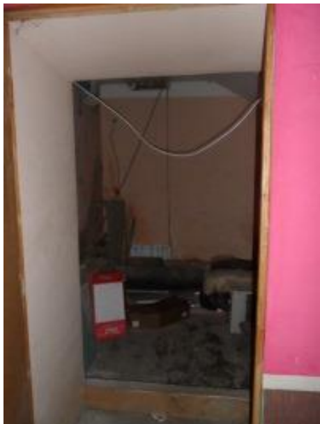
Фото 35. Часть помещения №1 помещения 6-Н, вид на вход с первого этажа
