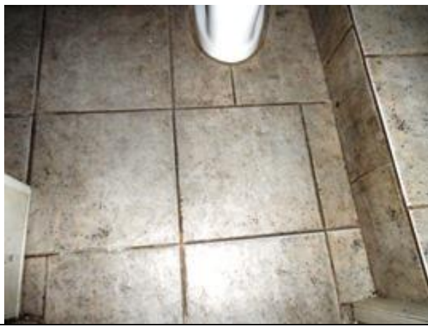
Фото 64. Часть помещения №8 помещения 6-Н, пол
