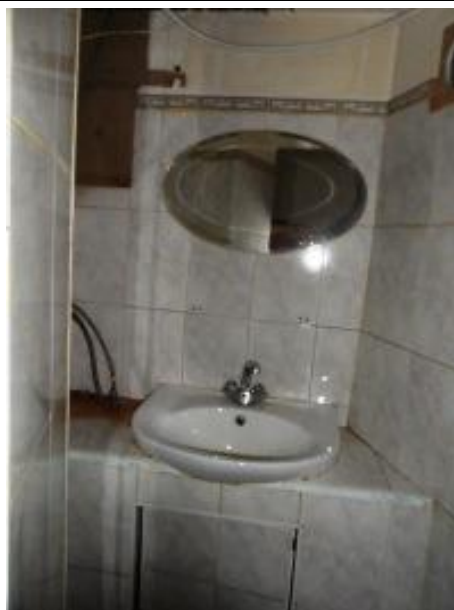
Фото 66. Часть помещения №8 помещения 6-Н
