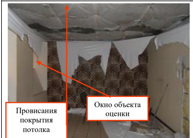
Фото 43. Часть помещения №5-6 помещения 6-Н
