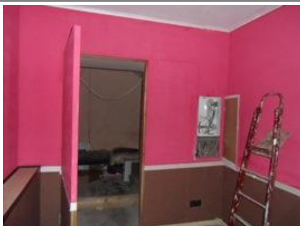
Фото 31. Часть помещения №1 помещения 6-Н, на часть помещения №3 помещения 6-Н
