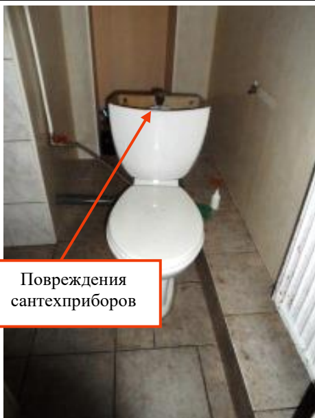
Фото 65. Часть помещения №8 помещения 6-Н
