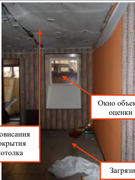
Фото 25. Часть помещения №3 помещения 6-Н, вид от коридора на окно и вход
