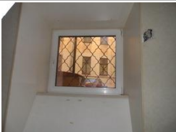
Фото 47. Часть помещения №5-6 помещения 6-Н, окно во двор
