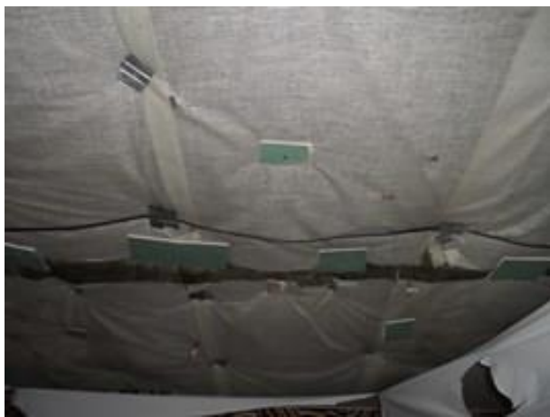
Фото 51. Часть помещения №5-6 помещения 6-Н, потолок
