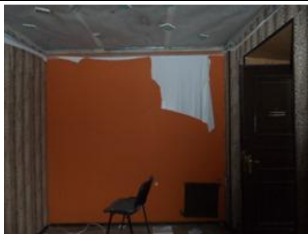
Фото 24. Часть помещения №2 помещения 6-Н
