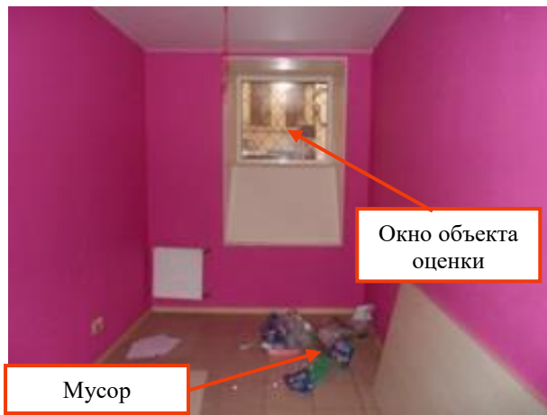
Фото 52. Часть помещения №6 помещения 6-Н, вид на окно
