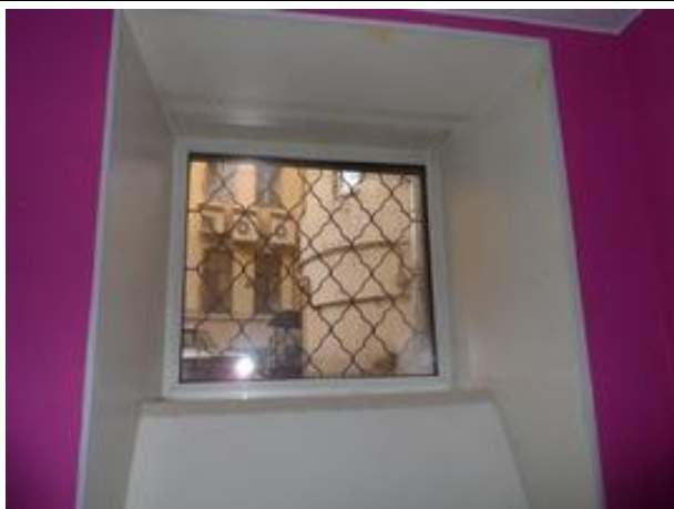
Фото 53. Часть помещения №6 помещения 6-Н, окно во двор
