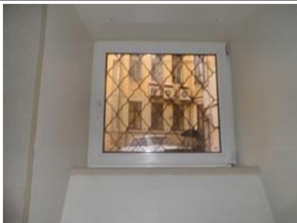
Фото 49. Часть помещения №5-6 помещения 6-Н, окно во двор
