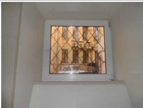
Фото 49. Часть помещения №5-6 помещения 6-Н, окно во двор
