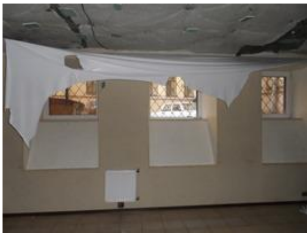
Фото 45. Часть помещения №5-6 помещения 6-Н, вид на окна от входа
