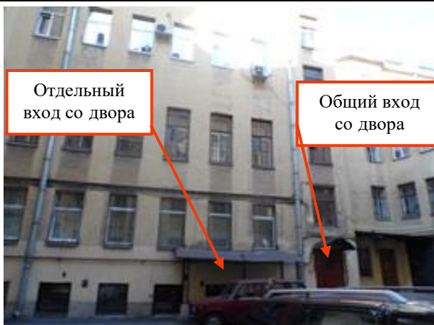
Фото 19. Входы в объект оценки со двора
