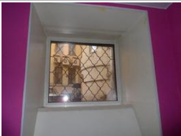
Фото 53. Часть помещения №6 помещения 6-Н, окно во двор
