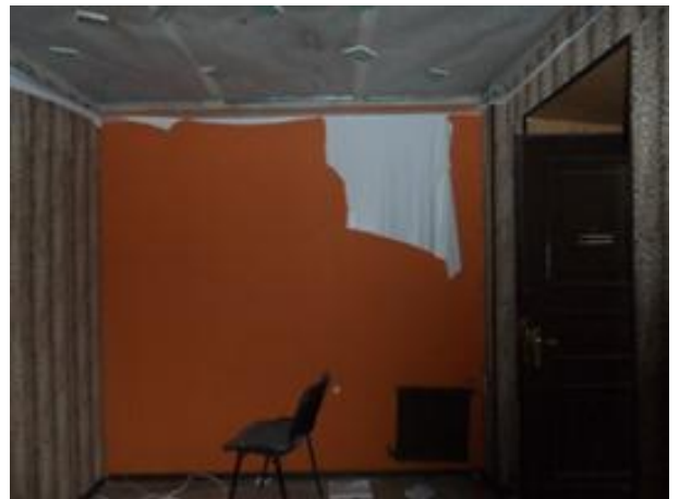
Фото 24. Часть помещения №2 помещения 6-Н
