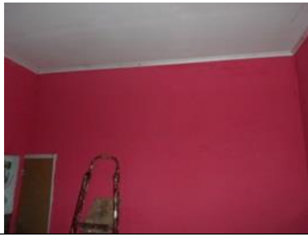
Фото 34. Часть помещения №1 помещения 6-Н
