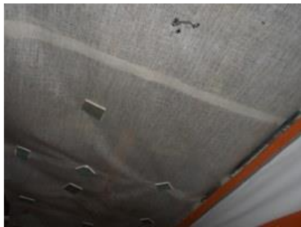
Фото 28. Часть помещения №2,3 помещения 6-Н, потолок
