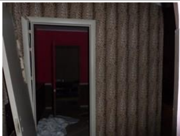
Фото 30. Часть помещения №3 помещения 6-Н, вид из коридора на часть помещения №1 помещения 6-Н
