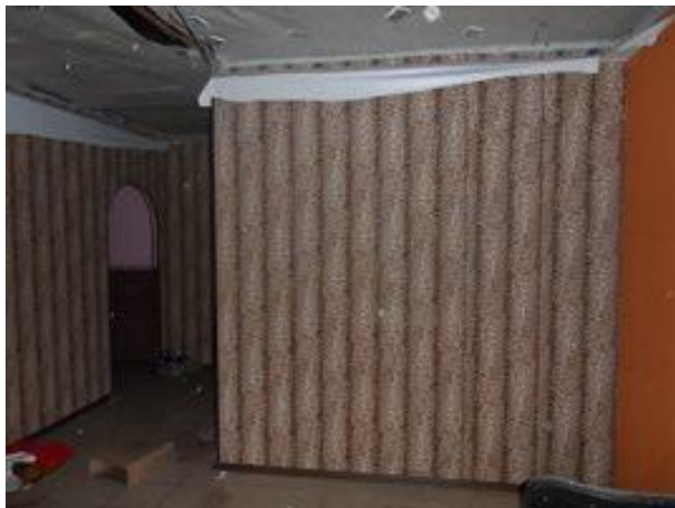
Фото 23. Части помещения №2-3 помещения 6-Н, вид от входа
