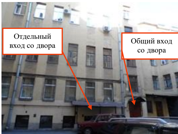
Фото 19. Входы в объект оценки со двора
