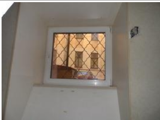
Фото 47. Часть помещения №5-6 помещения 6-Н, окно во двор
