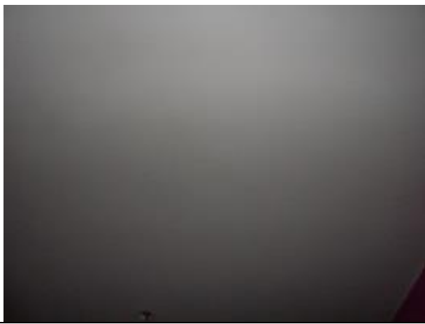
Фото 57. Часть помещения №6 помещения 6-Н, потолок
