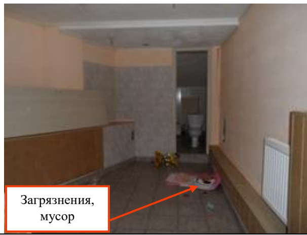
Фото 58. Часть помещения №7 помещения 6-Н, вид на часть помещения №8
