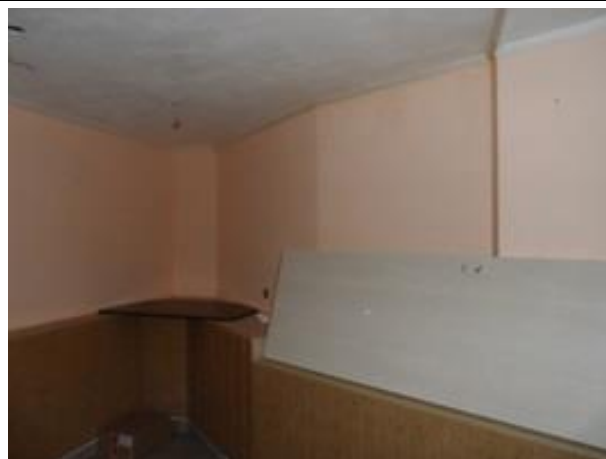
Фото 60. Часть помещения №7 помещения 6-Н
