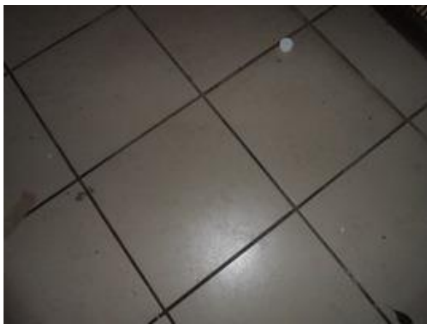
Фото 27. Часть помещения №2,3 помещения 6-Н, напольное покрытие
