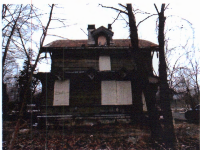
4. Восточный фасад здания.
