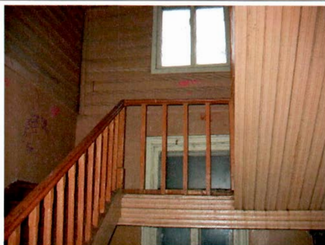
14. Лестница. Общий вид.
