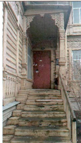
2. Крыльцо южного фасада.
