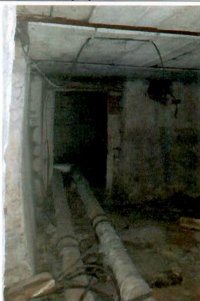
11. Помещения подвала. Общий вид.
