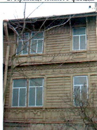
4. Фрагмент южного фасада.
