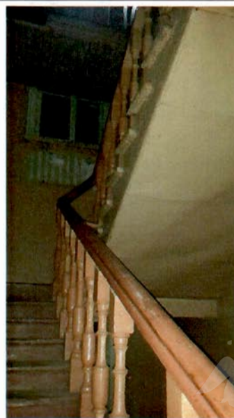
12. Лестница. Общий вид.
