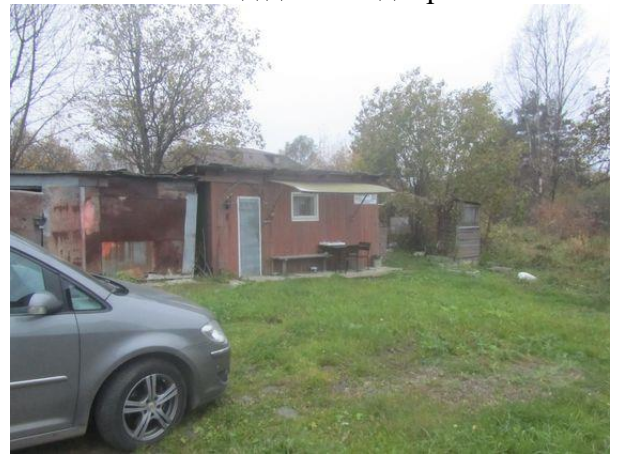
Фото 10. Состояние окружающей территории
