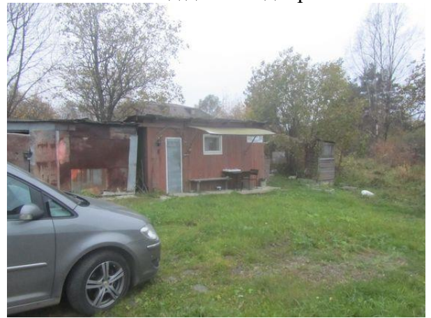
Фото 10. Состояние окружающей территории
