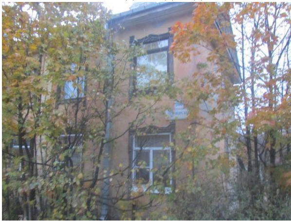
Фото 9. Номер дома на фасаде
