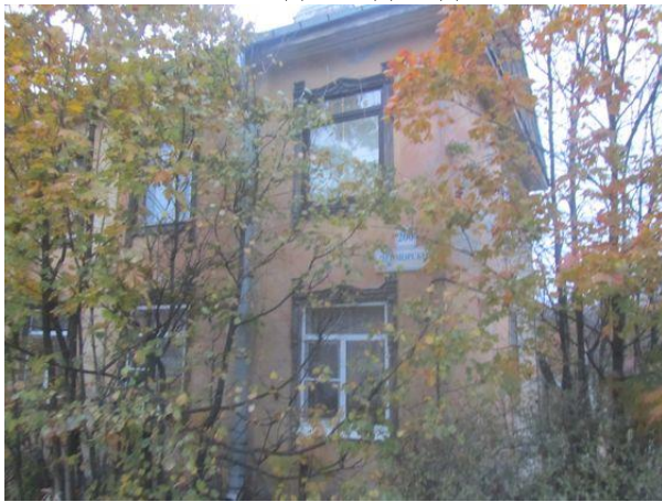
Фото 9. Номер дома на фасаде
