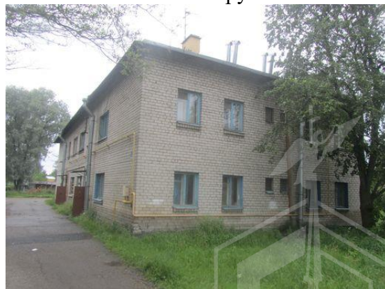
Фото 8. Общий вид дома № 22
