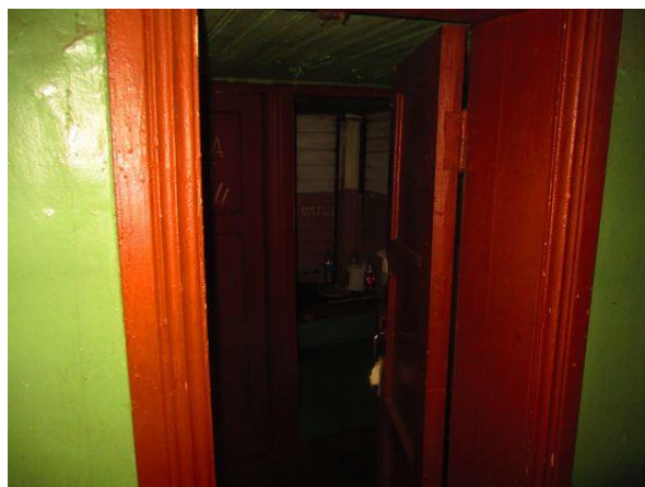
Фото 14. Вход в квартиру
