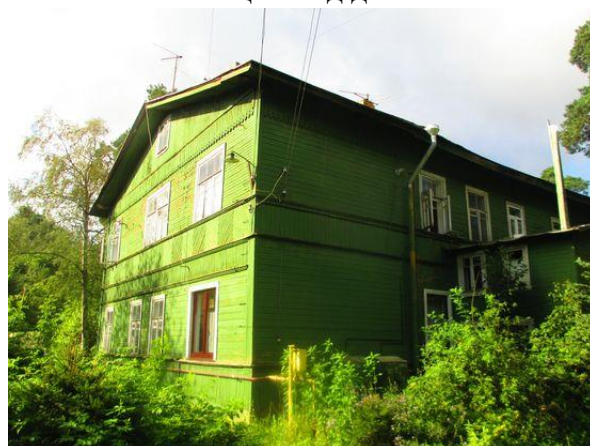
Фото 10. Общий вид дома
