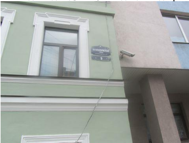
Фото 11. Номер дома на фасаде
