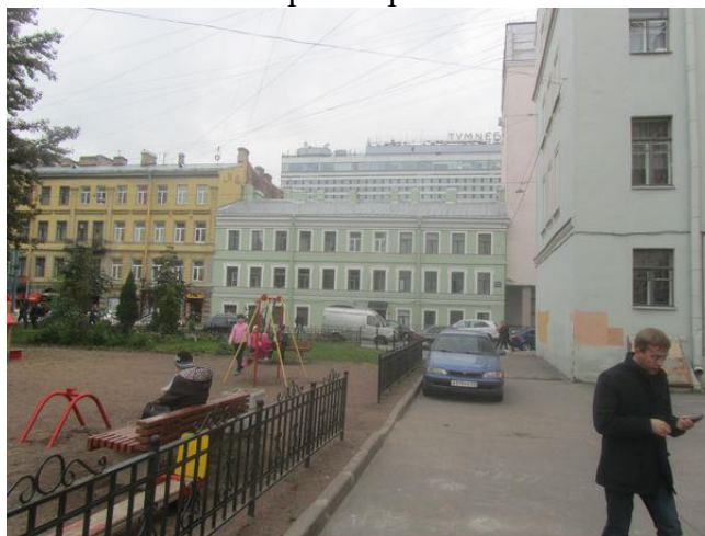
Фото 3. Фасад дома № 9 по 10-й Красноармейской ул.
