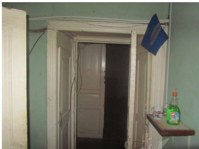
Фото 18. Выход на лестницу, ч.п. 7
