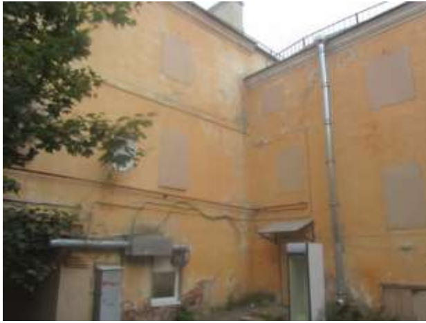
Фото 5. Фасад дома со двора, вход в подъезд
