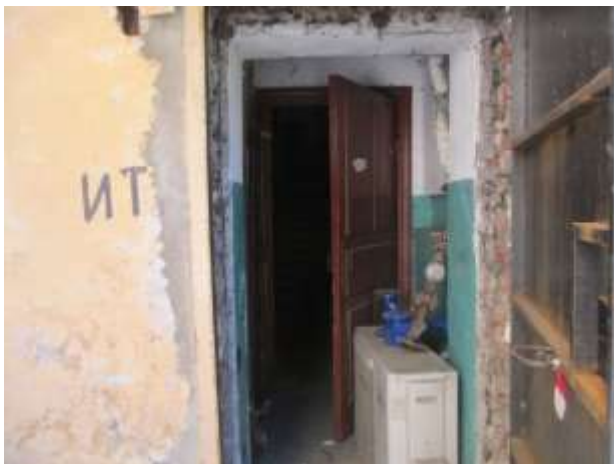
Фото 15. Вход в подвезд
