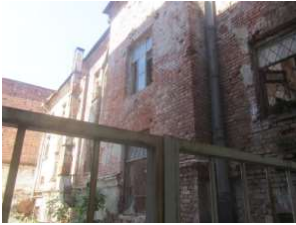
Фото 11. Фасад дома со двора (соседнее крыло дома)
