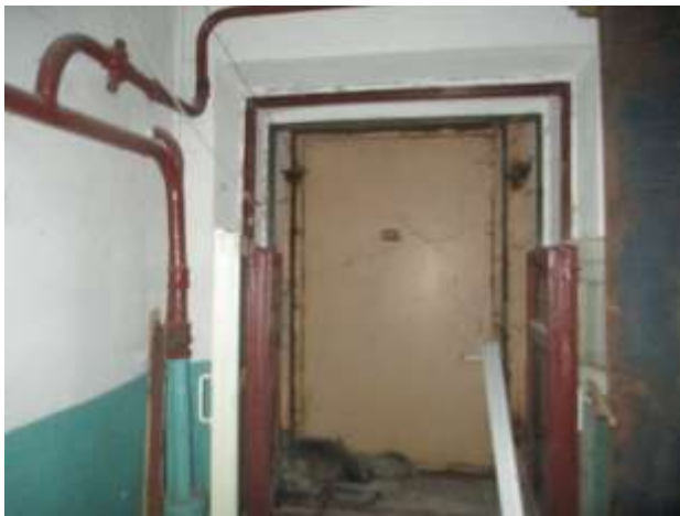
Фото 17. Вход на чердак
