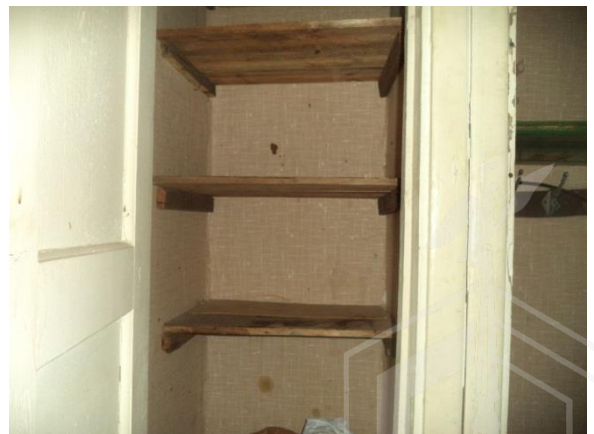
Фото 21 Общий вид и состояние помещения (ч.п. № 6)
