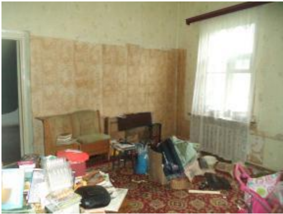
Фото 8 Общий вид и состояние помещения (ч.п. № 1)
