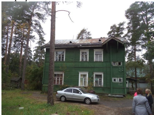
Фото 1 Внешний вид здания
