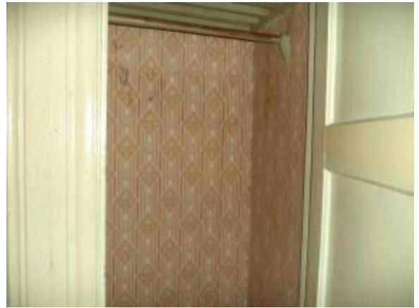
Фото 9 Общий вид и состояние помещения (ч.п. № 2)
