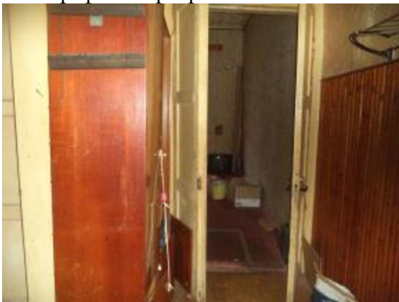
Фото 12 Общий вид и состояние помещения (ч.п. № 3)
