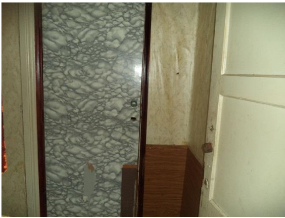
Фото 22 Общий вид и состояние помещения (ч.п. № 4 – тамбур)
