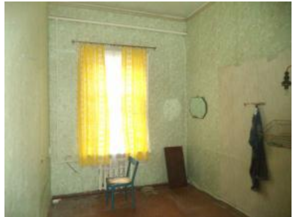
Фото 17 Общий вид и состояние помещения (ч.п. № 7)
