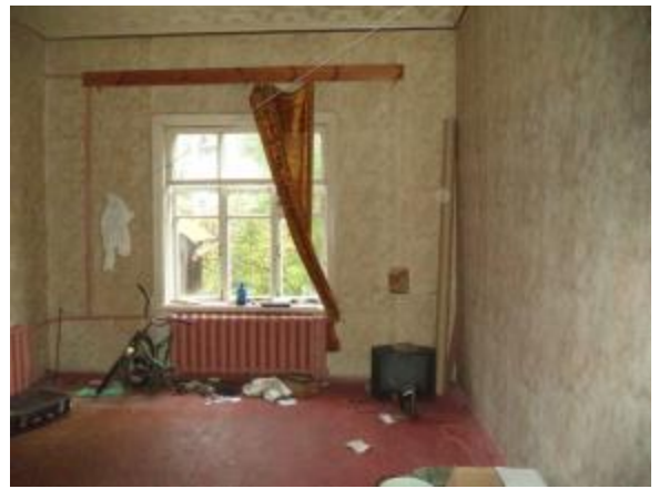
Фото 15 Общий вид и состояние помещения (ч.п. № 2)
