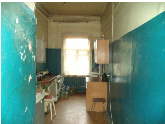
Фото 20 Общий вид и состояние помещения (ч.п. № 5)
