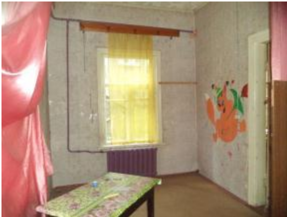
Фото 16 Общий вид и состояние помещения (ч.п. № 1)
