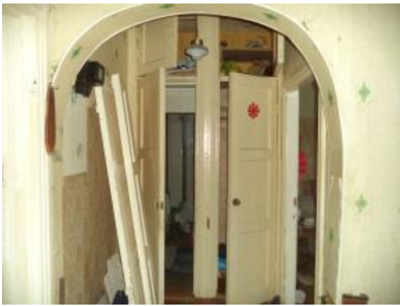
Фото 6 Общий вид и состояние помещения (ч.п. № 4)
