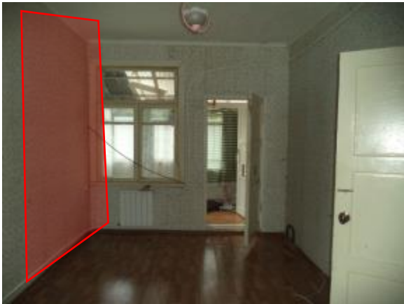
Фото 10 Общий вид и состояние помещения (ч.п. № 8, перепланировка: демонтирована перегородка, заложены оконные проемы: красный цвет)
