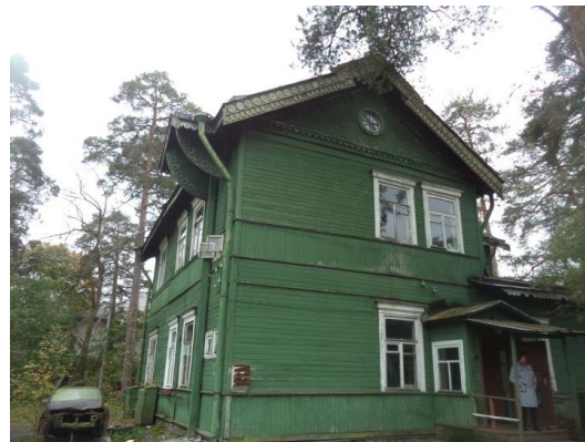
Фото 2 Внешний вид здания
