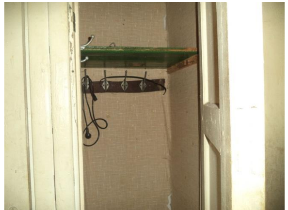
Фото 19 Общий вид и состояние помещения (ч.п. № 11)
