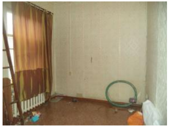
Фото 7 Общий вид и состояние помещения (ч.п. № 6)
