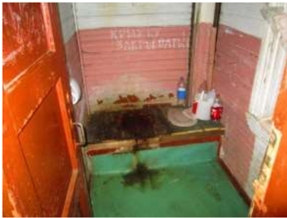
Фото 33. Общий туалет между 1 и 2 этажом
