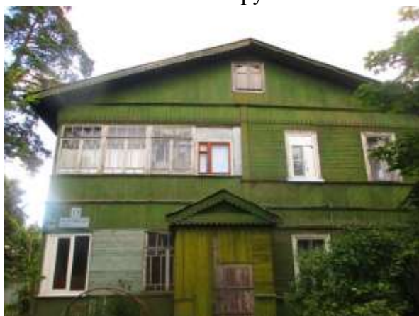
Фото 9. Общий вид дома
