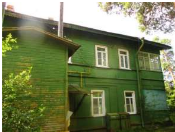
Фото 38. Общий вид дома
