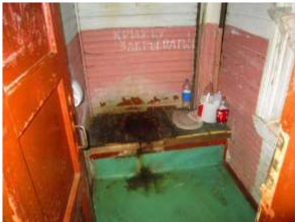
Фото 63. Общий туалет между 1 и 2 этажом
