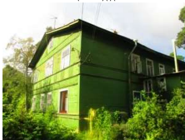
Фото 40. Общий вид дома
