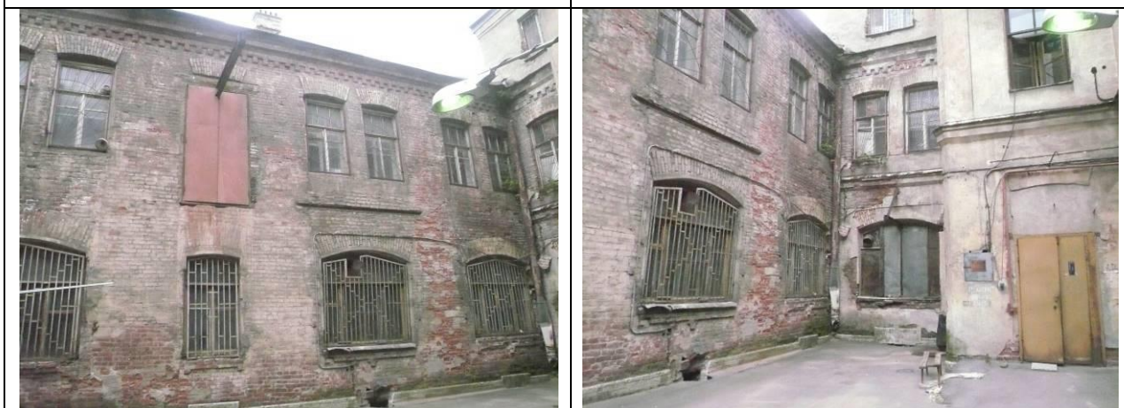
Фото здания двор
