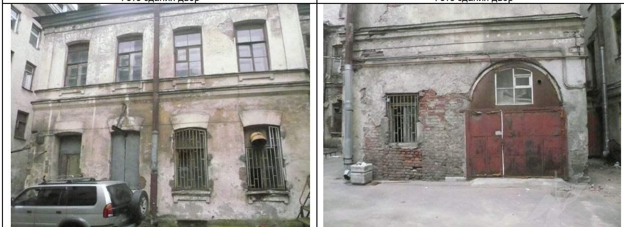
Фото здания двор
