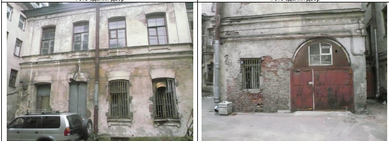
Фото здания двор
