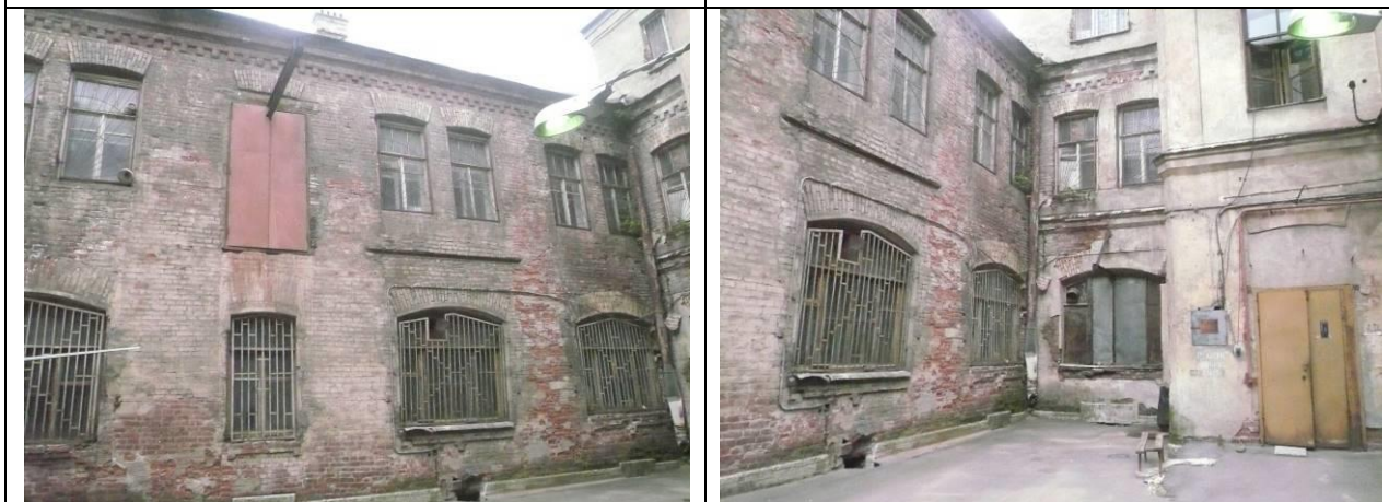
Фото здания двор
