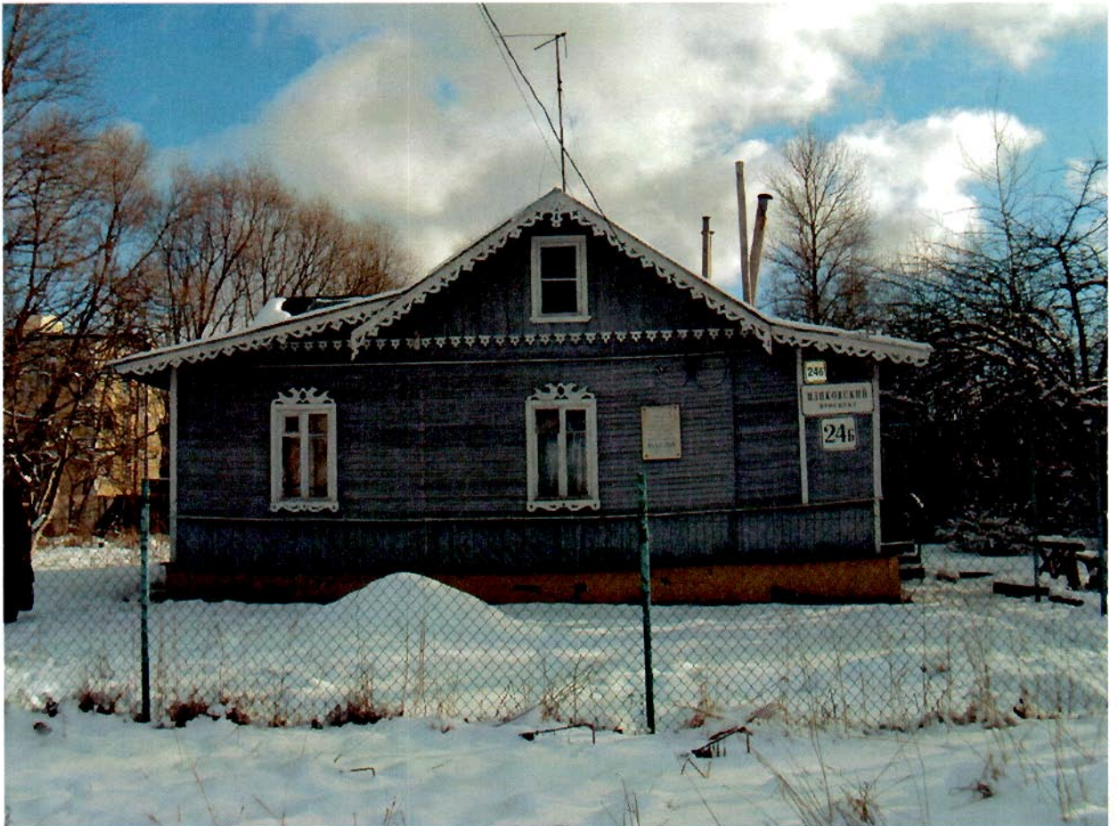
Фото 1. Фасад с западной стороны.
