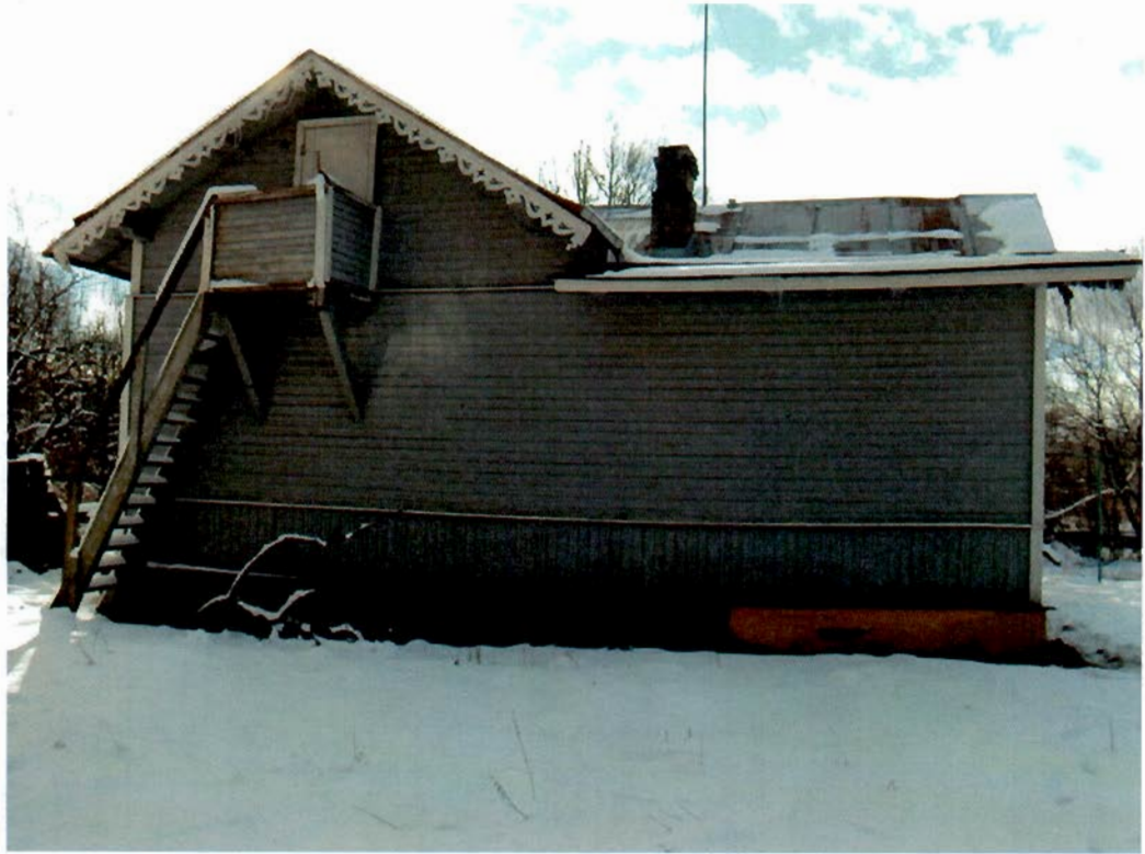
Фото 4. Фасад с северной стороны.
