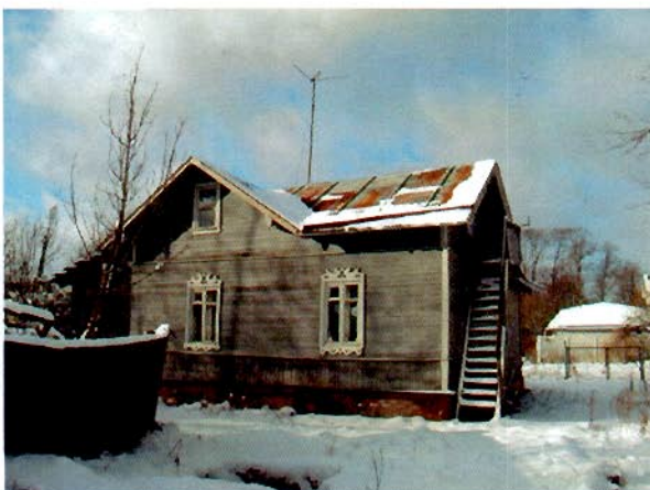
Фото 2. Фасад с восточной стороны.
