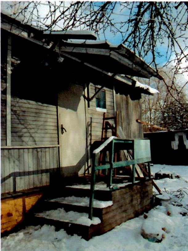
Фото 5. Крыльцо со стороны южного фасада.
