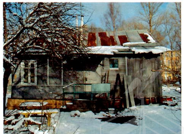
Фото 3. Фасад с южной стороны.
