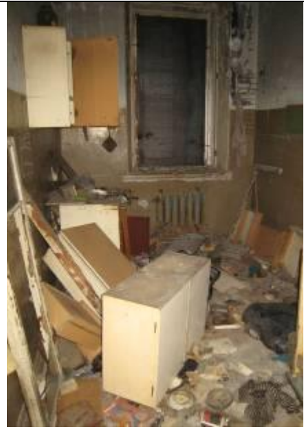
Фото 20 Вид части помещения 10
