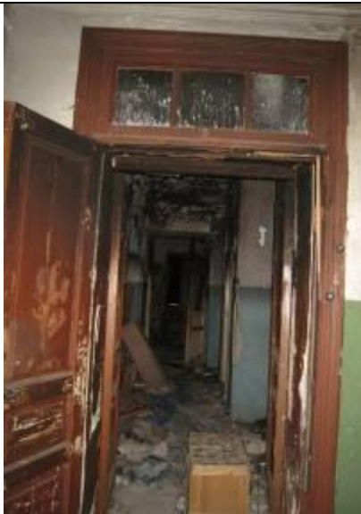
Фото 17 Вид части помещения 7
