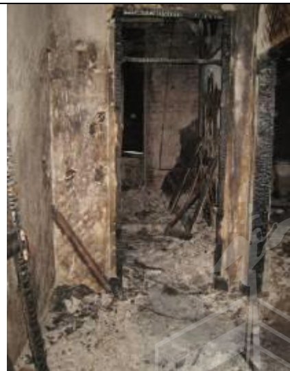
Фото 22 Вид части помещения 6
