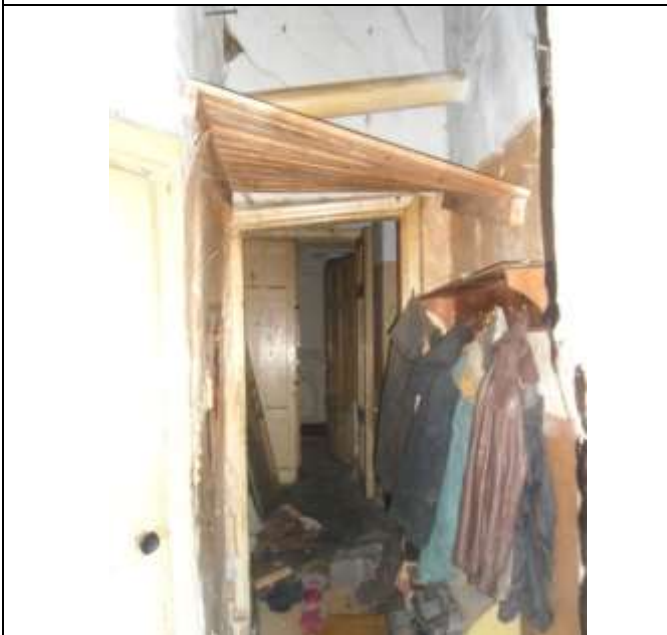
Фото 37 Вид коридора между ч.п.7 и8
