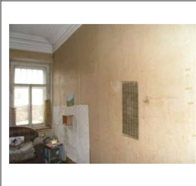
Фото 35 Вид части помещения №8
