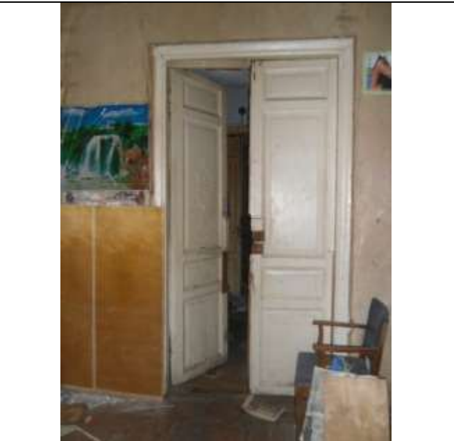
Фото 36 Вид части помещения №8
