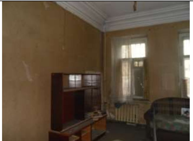
Фото 34 Вид части помещения №8
