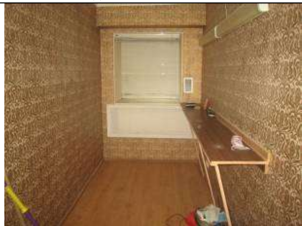
Фото 30 Вид части помещения №7(перепланировка: оборудована перегородка)
