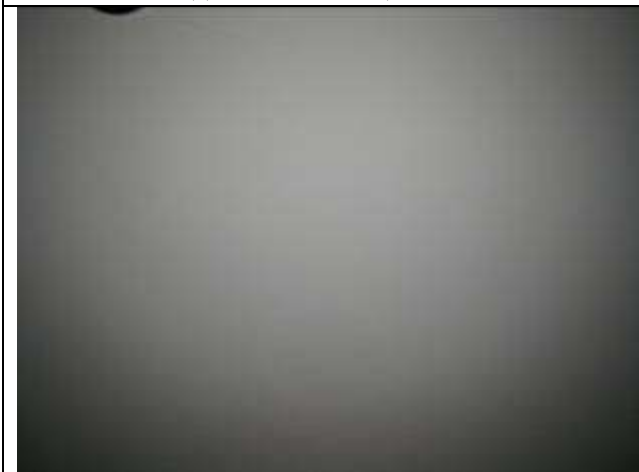
Фото 29 Вид потолка части помещения №8
