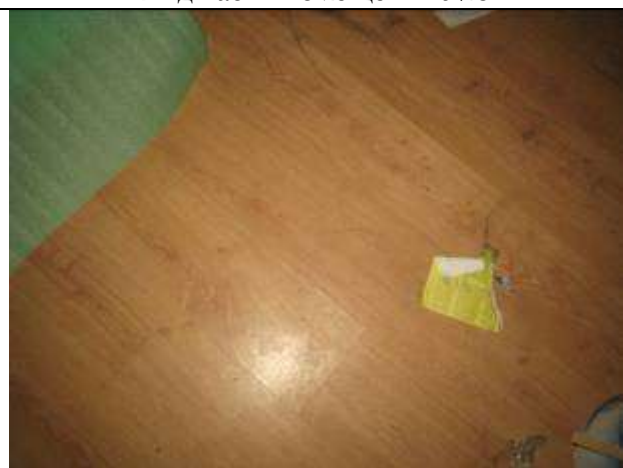
Фото 28 Вид пола части пом.№8
