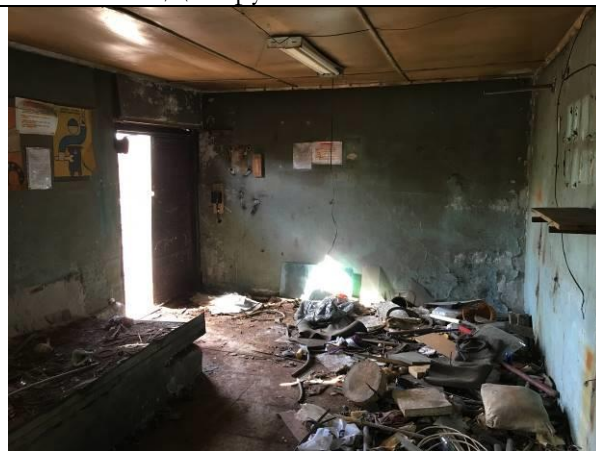
Фото 28 Бытовые помещения, 1-й этаж
