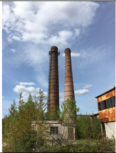
Фото 26 Две трубы котельной
