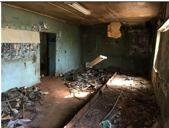
Фото 27 Бытовые помещения, 1-й этаж
