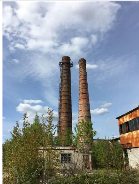
Фото 26 Две трубы котельной
