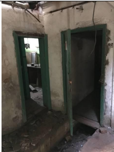
Фото 29 Бытовые помещения 1 этажа
