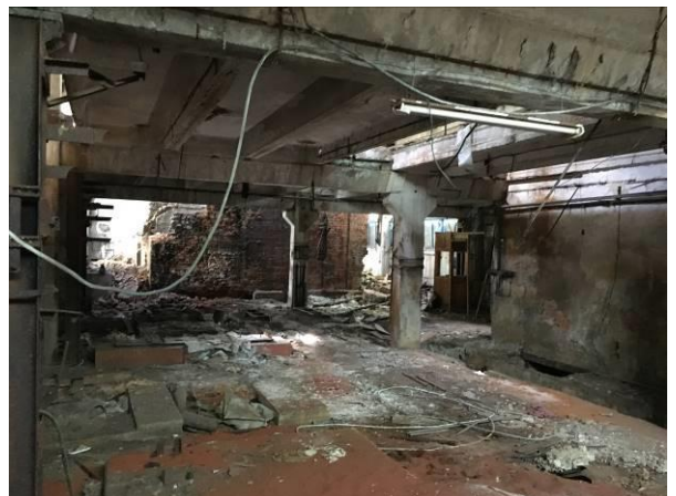
Фото 30 Общий вид помещений, 1-й этаж
