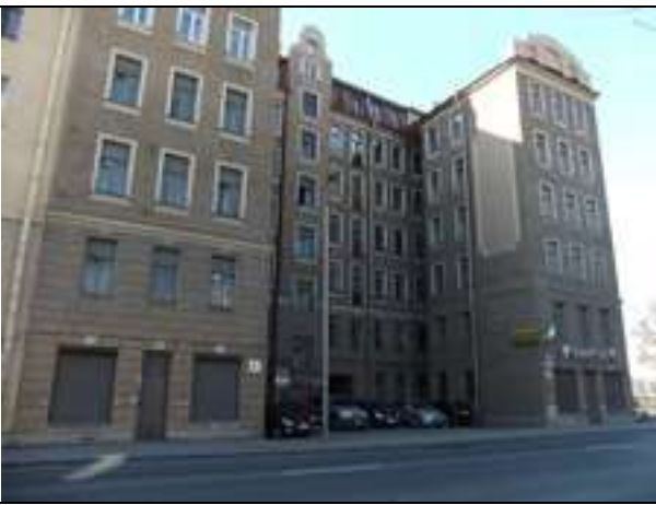
Фасад здания размещения Объекта оценки
