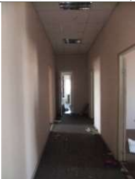
Состояние отделки Объекта оценки, ч.п. 1
