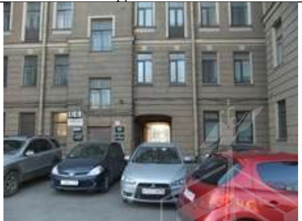
Фасад здания размещения Объекта оценки (вид со стороны р. Большая Невка) (условия для парковки)
