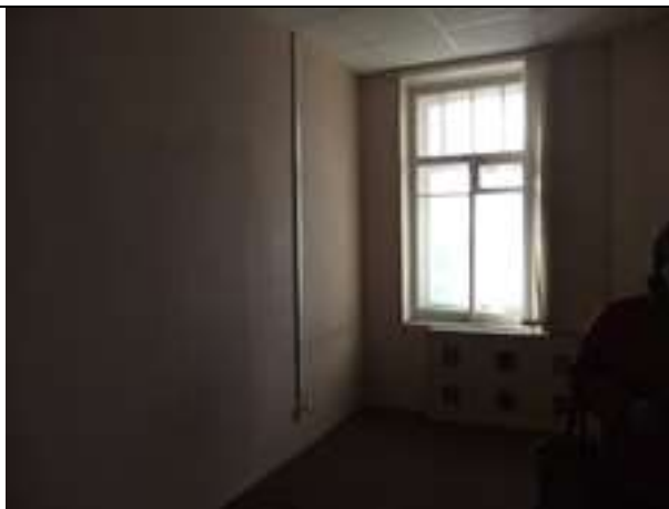
Состояние отделки Объекта оценки, ч.п. 3
