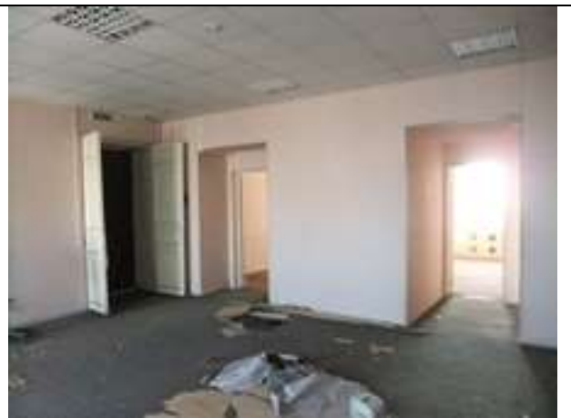
Состояние отделки Объекта оценки, ч.п. 1
