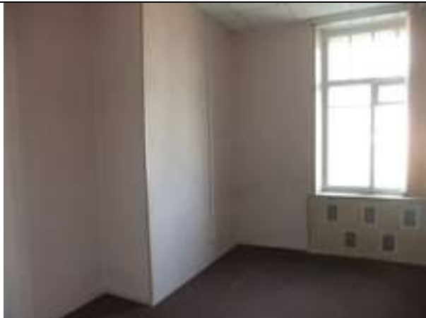
Состояние отделки Объекта оценки, ч.п. 11
