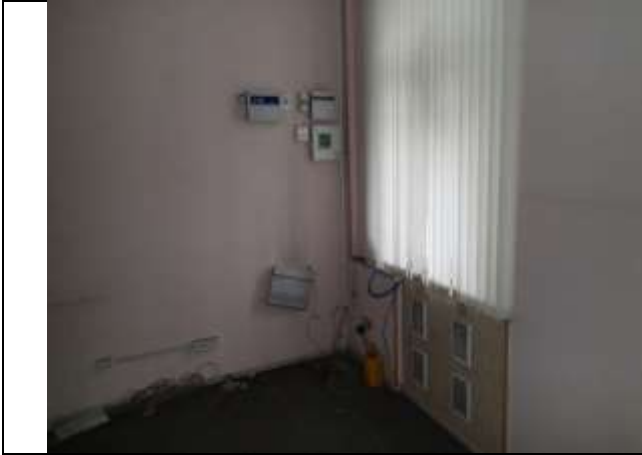
Состояние отделки Объекта оценки, ч.п. 1
