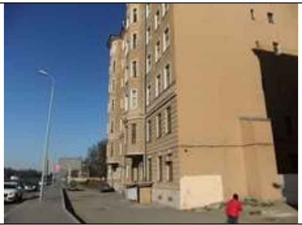
Фасад здания размещения Объекта оценки
