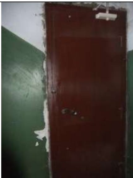
Входная дверь Объекта оценки, вход осуществляется в ч.п. 10 (вид снаружи)
