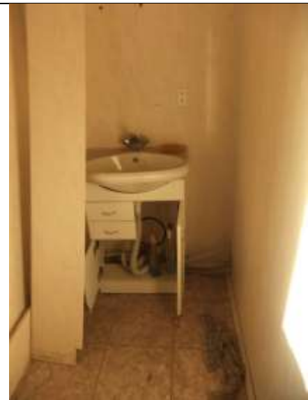
Состояние отделки Объекта оценки, ч.п. 8
