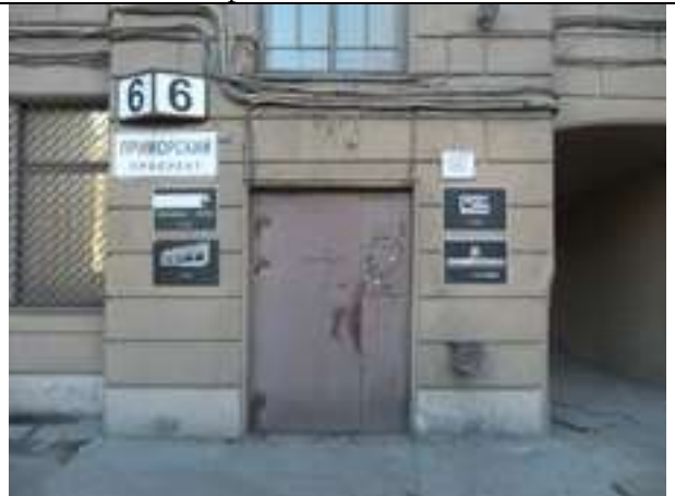
Вход в подъезд Объекта оценки
