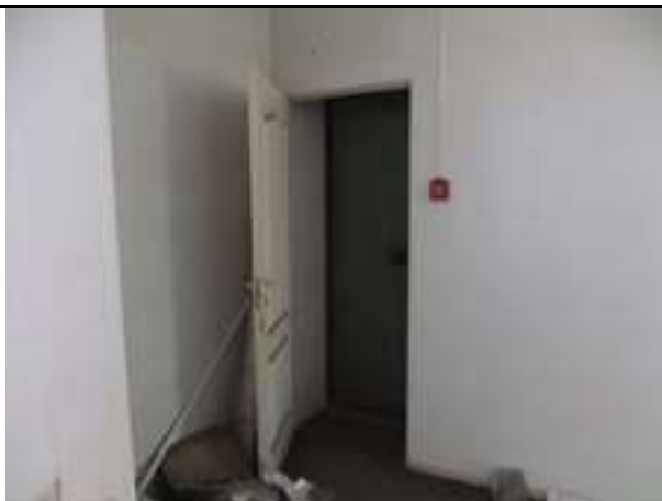
Состояние отделки Объекта оценки, ч.п. 10
