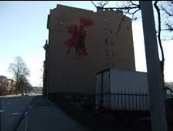
Фасад здания размещения Объекта оценки
