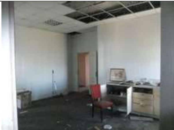
Состояние отделки Объекта оценки, ч.п. 10
