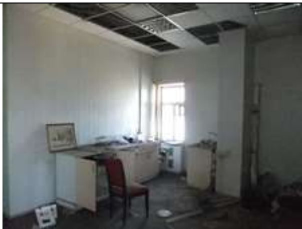
Состояние отделки Объекта оценки, ч.п. 10
