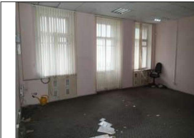
Состояние отделки Объекта оценки, ч.п. 1
