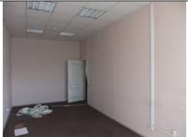
Состояние отделки Объекта оценки, ч.п. 4
