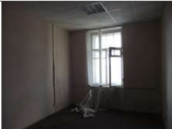
Состояние отделки Объекта оценки, ч.п. 5
