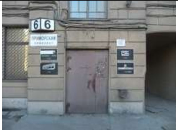
Вход в подъезд Объекта оценки
