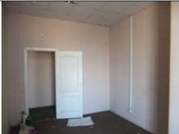
Состояние отделки Объекта оценки, ч.п. 11
