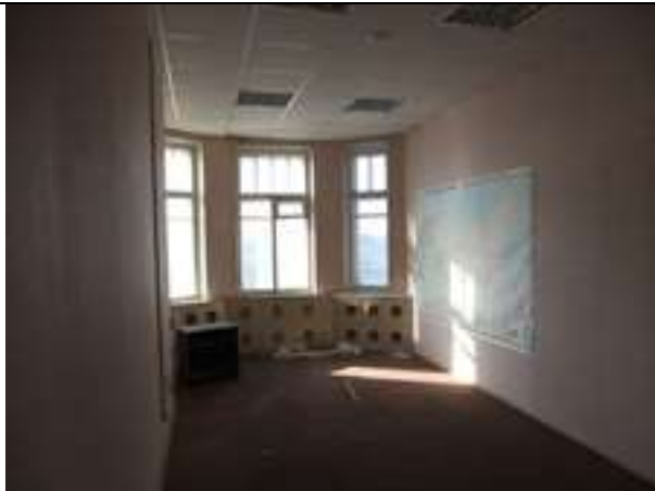
Состояние отделки Объекта оценки, ч.п. 4
