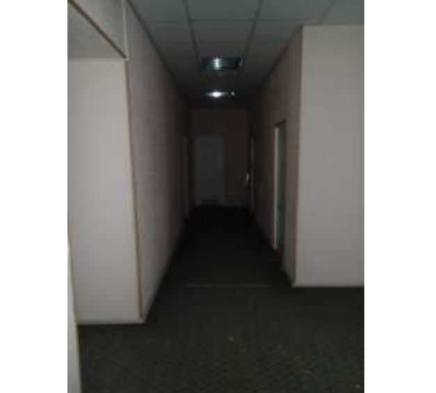
Состояние отделки Объекта оценки, ч.п. 1
