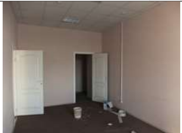
Состояние отделки Объекта оценки, ч.п. 5
