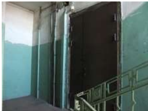
Входная дверь Объекта оценки, вход осуществляется в ч.п. 1 (вид снаружи)
