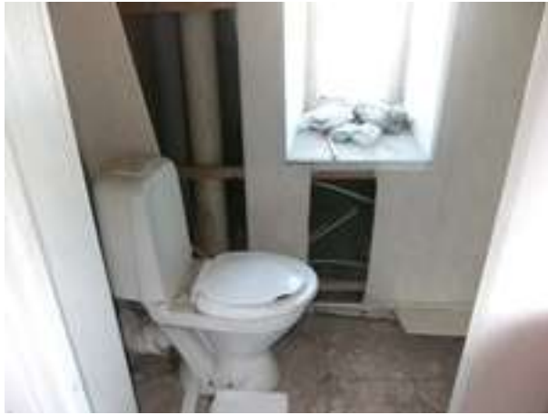
Состояние отделки Объекта оценки, вид из ч.п. 7 в ч.п. 8
