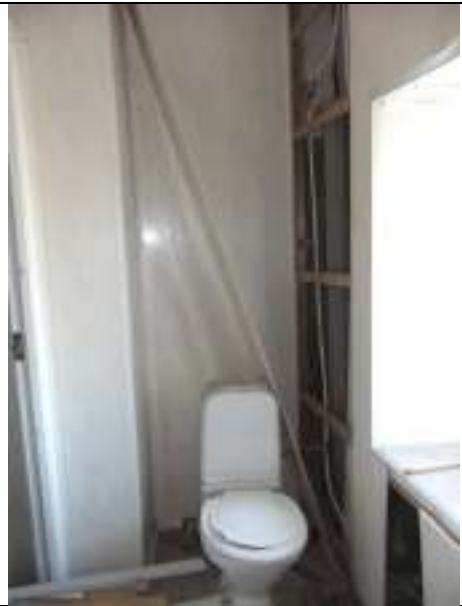
Состояние отделки Объекта оценки, ч.п. 8
