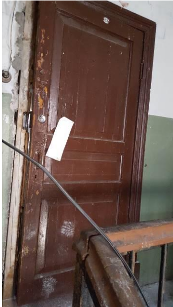
Фото 1 Входная дверь в кв.№53
