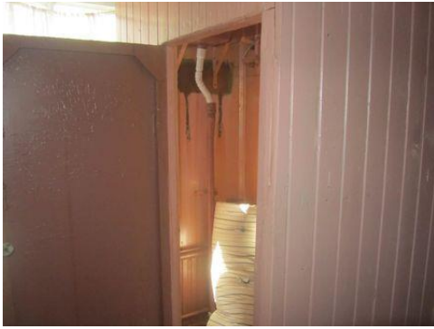
Фото 31. Вход в туалет
