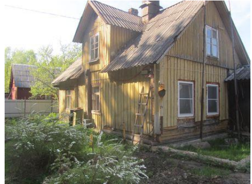
Фото 10. Общий вид дома
