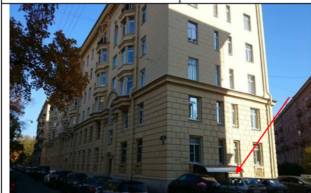
Фото 9 Вид входа в объект оценки (ота/ул) снаружи
