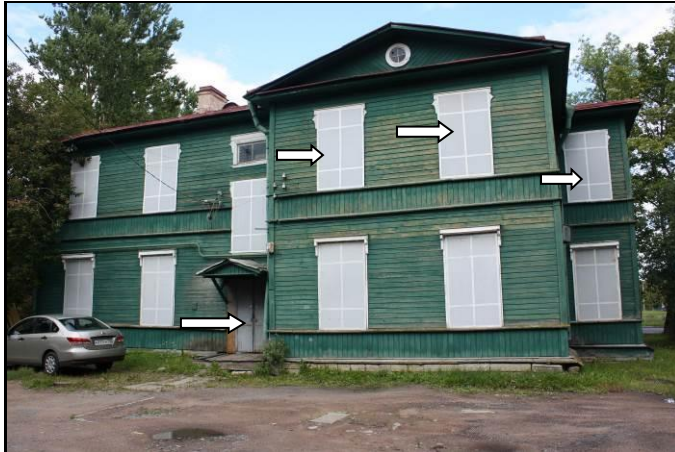
Фото 61: Фасад здания (вид с улицы/со двора). Расположение общего с жилыми помещениями входа. Окна оцениваемой квартиры
