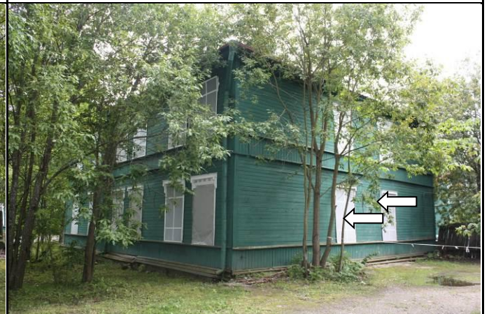
Фото 34: Фасад здания (вид со двора). Окна оцениваемой квартиры
