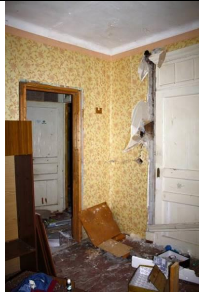
Фото 86: Общий вид 7, вид на ч.п.9. Оборудован дверной проем.
