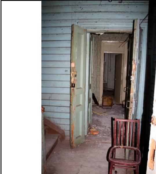
Фото 45: Входные двери в оцениваемую квартиру
