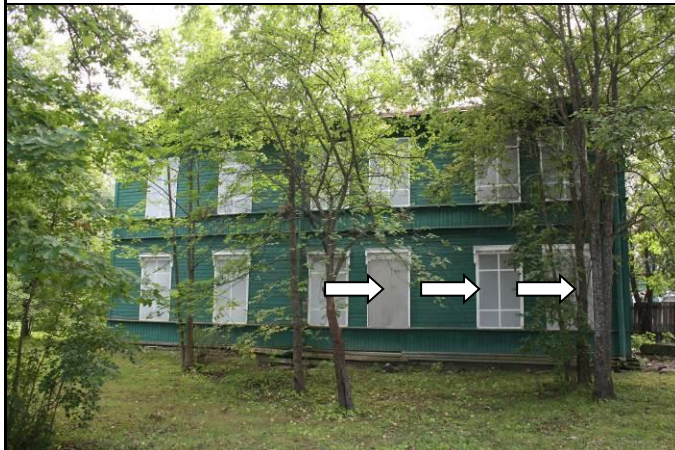
Фото 33: Фасад здания (вид с улицы). Окна оцениваемой квартиры
