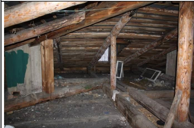
Фото 59: Общий вид чердака здания
