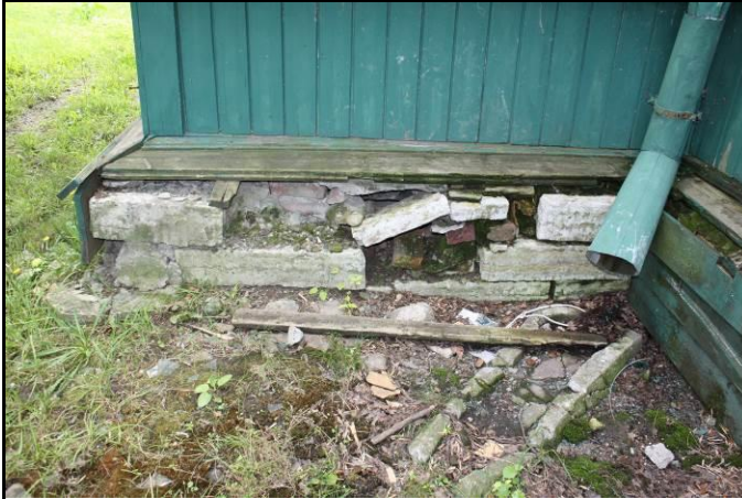
Фото 43: Общее состояние фундамента здания
