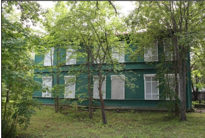
Фото 3: Фасад здания (вид с улицы).
