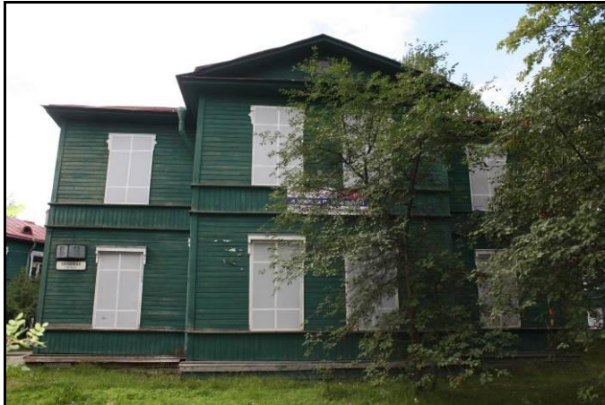
Фото 97: Фасад здания (вид с улицы)
