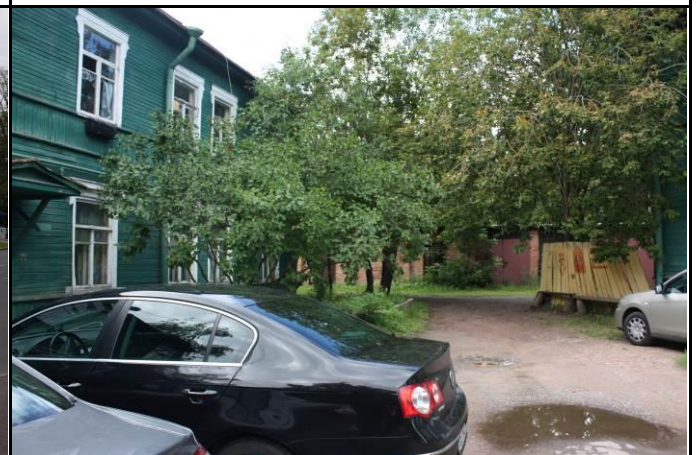
Фото 70: Прилегающая территория (двор), соседнее жилое здание
