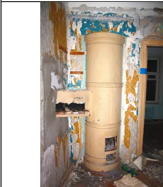
Фото 83: Общий вид ч.п.11, вид на ч.п.10. Печь, не отображенная на плане.
