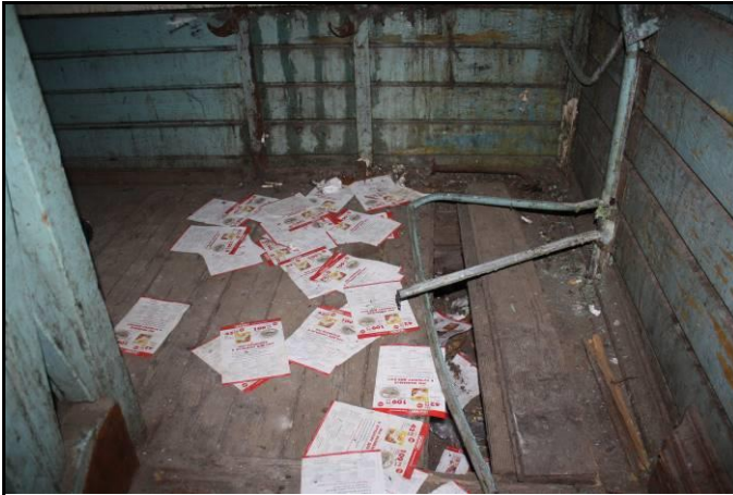
Фото 91: Общее состояние лестничного пролета
