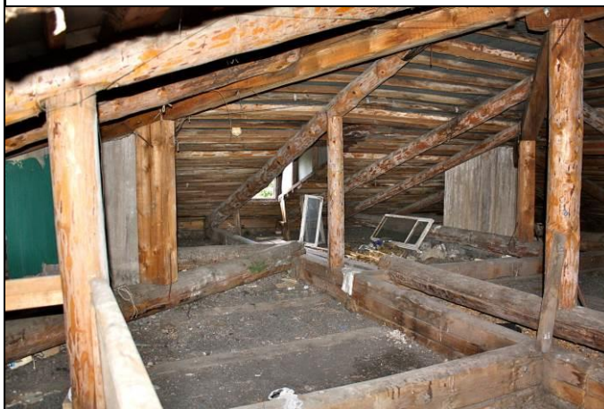
Фото 29: Общий вид чердака здания
