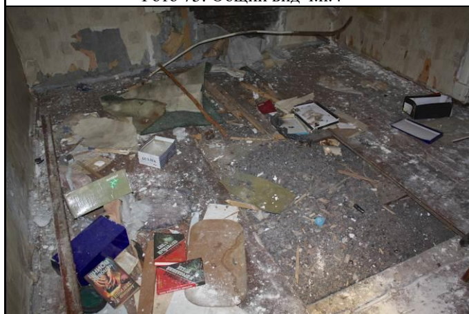
Фото 77: Состояние отделки напольного покрытия в оцениваемой квартире
