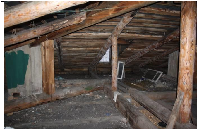
Фото 93: Общий вид чердака здания
