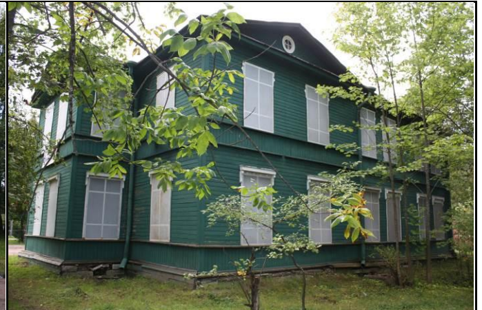
Фото 32: Фасад здания (вид с улицы).
