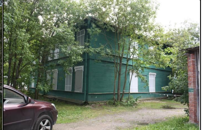
Фото 64: Фасад здания (вид со двора)
