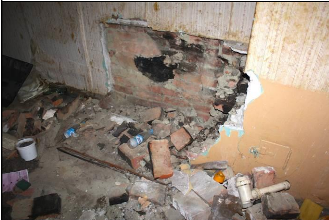
Фото 111: Ч.п.8. Демонтирована дровяная плита, обозначенная на плане
