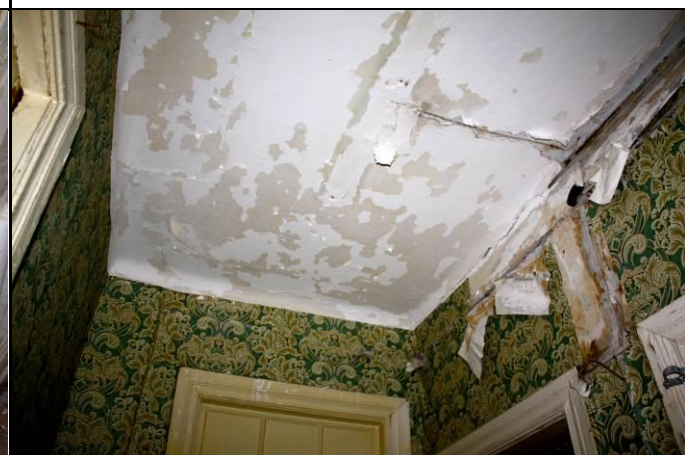
Фото 52: Общее состояние потолочного покрытия в ч.п. оцениваемой квартиры
