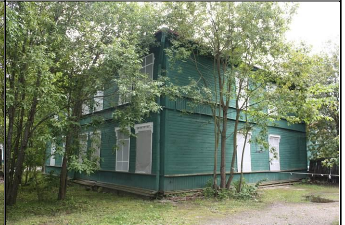
Фото 4: Фасад здания (вид со двора)
