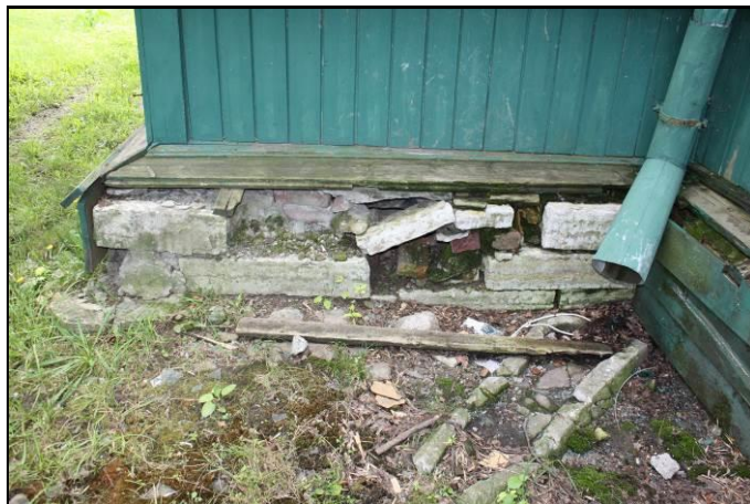
Фото 13: Общее состояние фундамента здания
