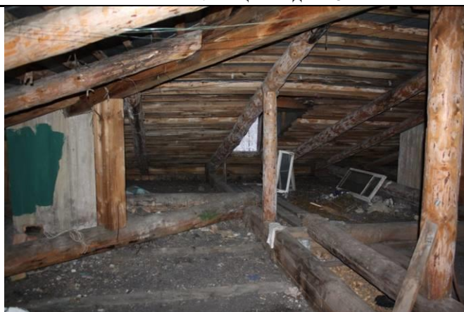
Фото 123: Общий вид чердака здания
