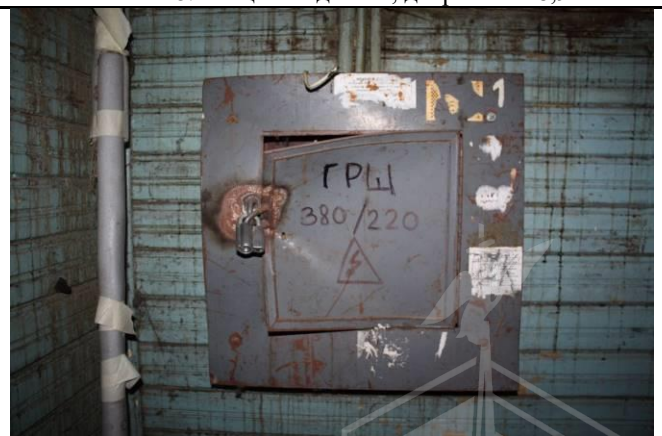
Фото 30: Главный распределительный щит здания
