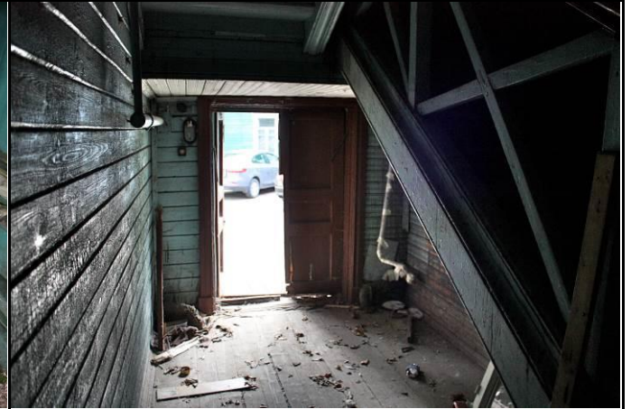
Фото 44: Общий вид подьезда
