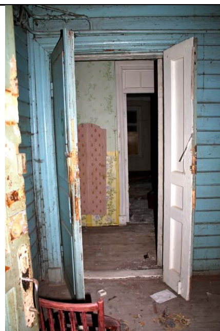
Фото 16: Входные двери в оцениваемую квартиру
