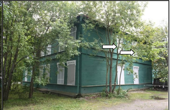
Фото 98: Фасад здания (вид со двора). Окна оцениваемой квартиры
