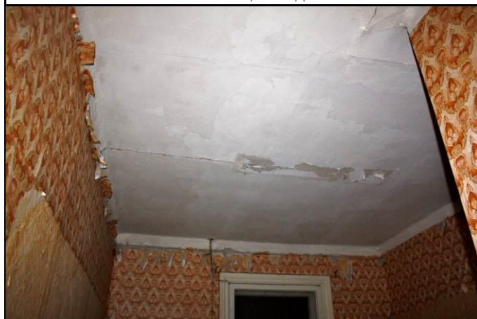
Фото 27: Общее состояние потолков в оцениваемой квартире
