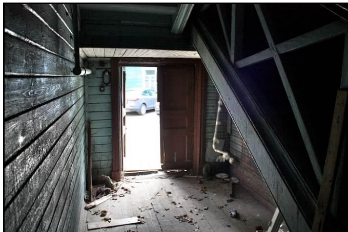
Фото 73: Общий вид подъезда
