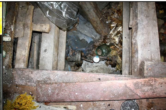
Фото 50: Водомерный узел в ч.п.8
