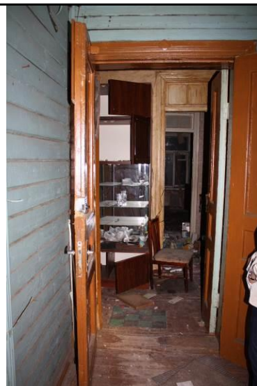
Фото 74: Входные двери в оцениваемую квартиру
