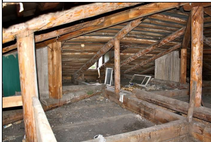
Фото 29: Общий вид чердака здания
