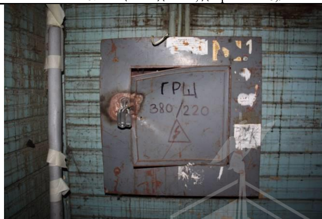
Фото 30: Главный распределительный щит здания
