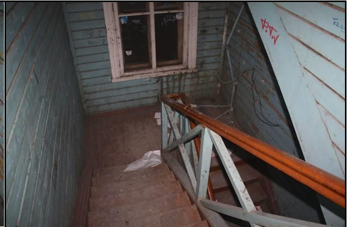
Фото 92: Общее состояние лестничного пролета
