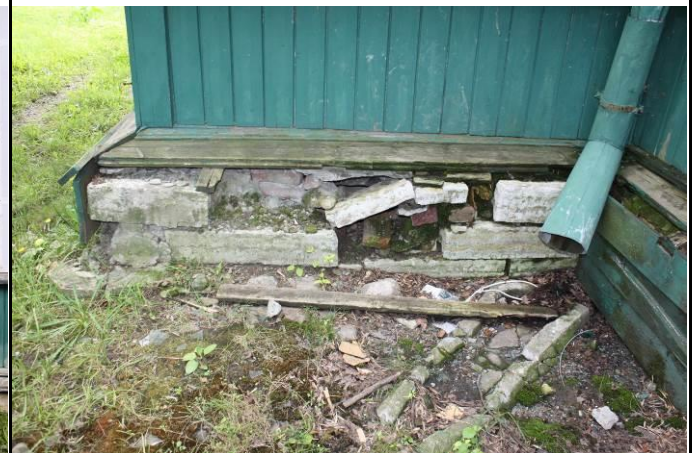
Фото 106: Общее состояние фундамента здания
