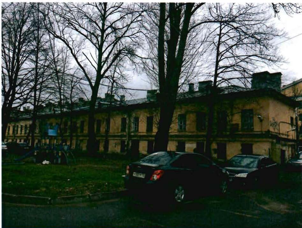
Фото 3. Западный дворовый фасад.
