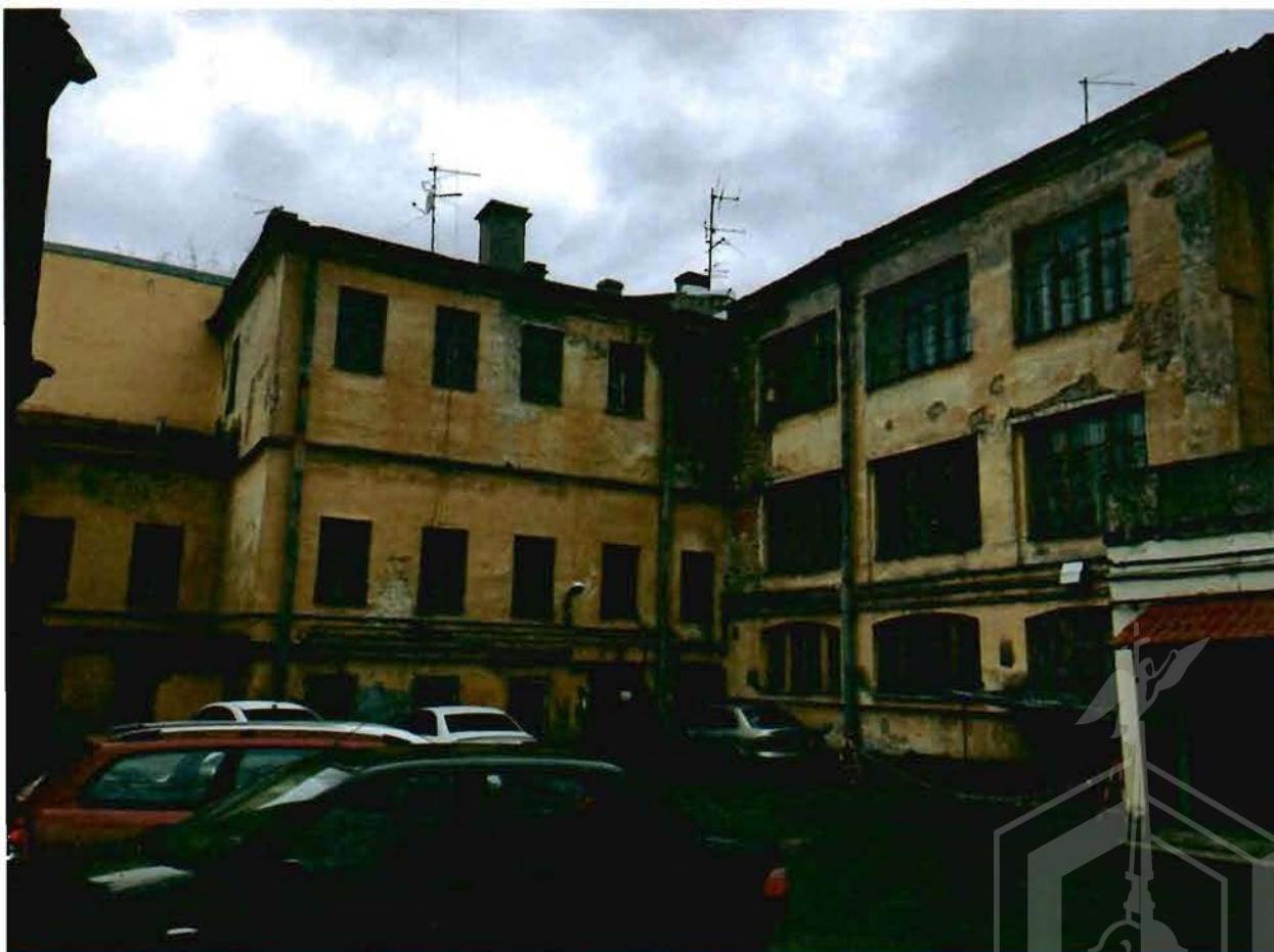
Фото 6. Южный и восточный дворовый фасад.
