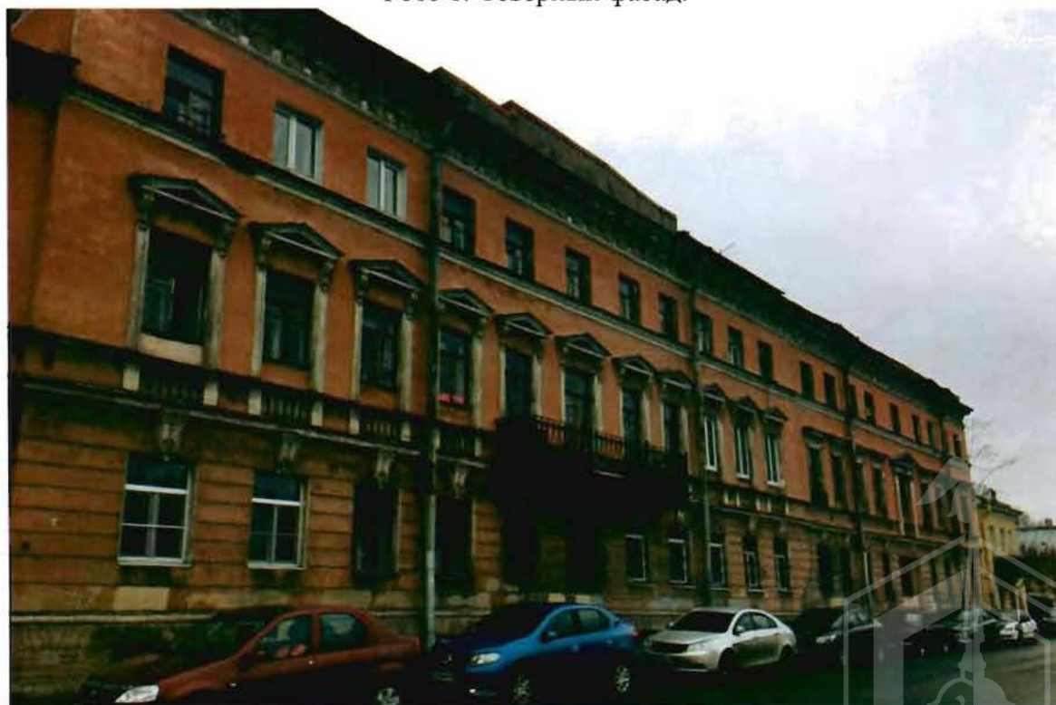
Фото 2. Часть северного фасада.
