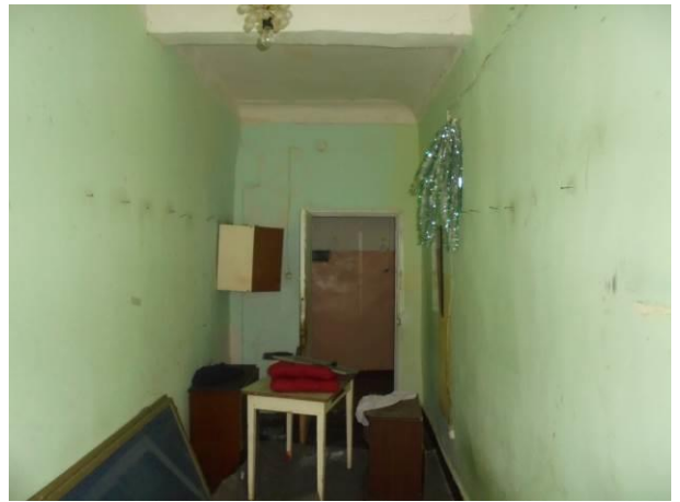
Фото 14. Общий вид и состояние квартиры
