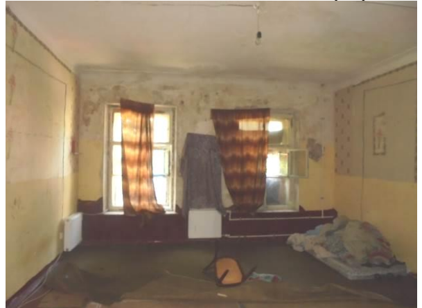
Фото 16. Общий вид и состояние квартиры
