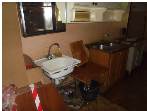
Фото 22. Общий вид и состояние квартиры
