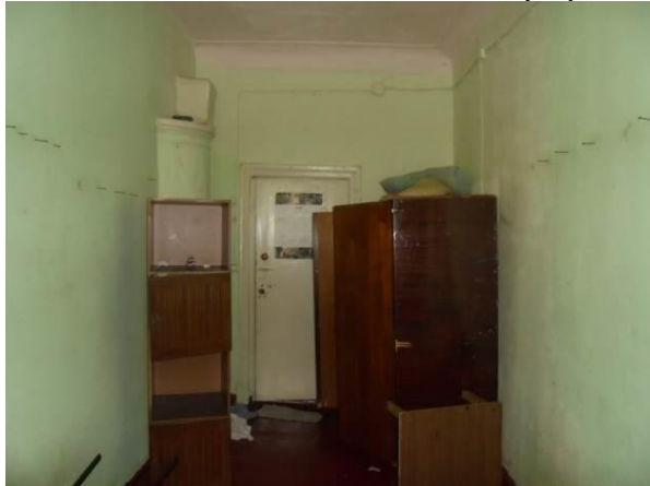
Фото 15. Общий вид и состояние квартиры
