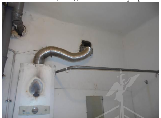
Фото 20. Общий вид и состояние квартиры
