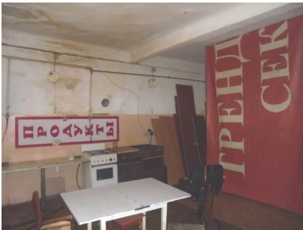
Фото 11. Общий вид и состояние квартиры
