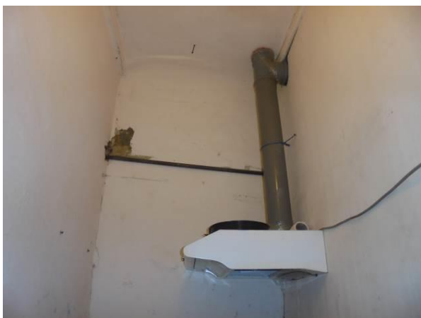
Фото 21. Общий вид и состояние квартиры
