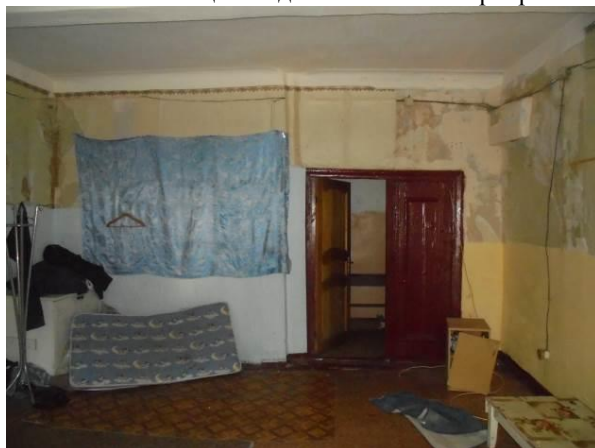
Фото 17. Общий вид и состояние квартиры
