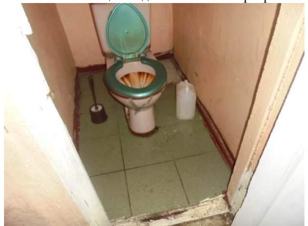
Фото 18. Общий вид и состояние квартиры
