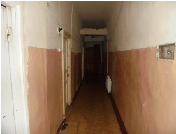
Фото 13. Общий вид и состояние квартиры
