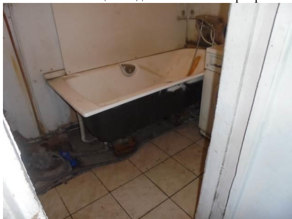
Фото 19. Общий вид и состояние квартиры
