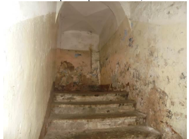
Фото 10. Общий вид и состояние помещений общего пользования (лестница)
