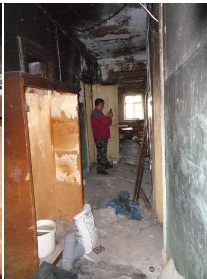
Фото 14 Общий вид и состояние квартиры
