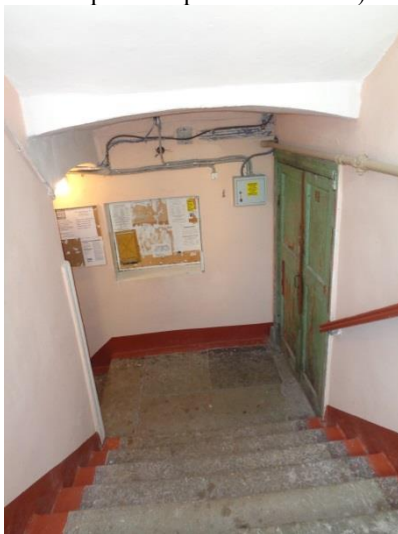
Фото 11. Общий вид и состояние помещений общего пользования (лестница)
