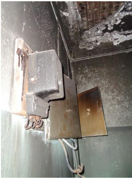
Фото 25 Общий вид и состояние квартиры
