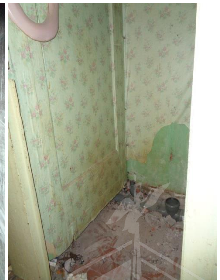
Фото 15 Общий вид и состояние квартиры
