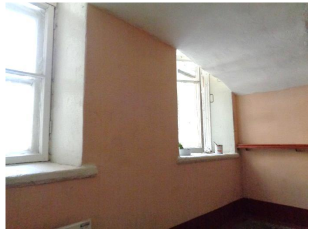
Фото 12. Общий вид и состояние помещений общего пользования (лестница)
