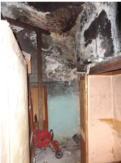
Фото 13 Общий вид и состояние квартиры
