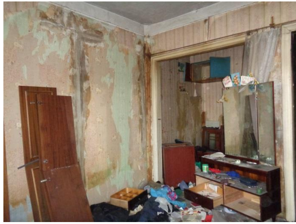
Фото 26 Общий вид и состояние квартиры
