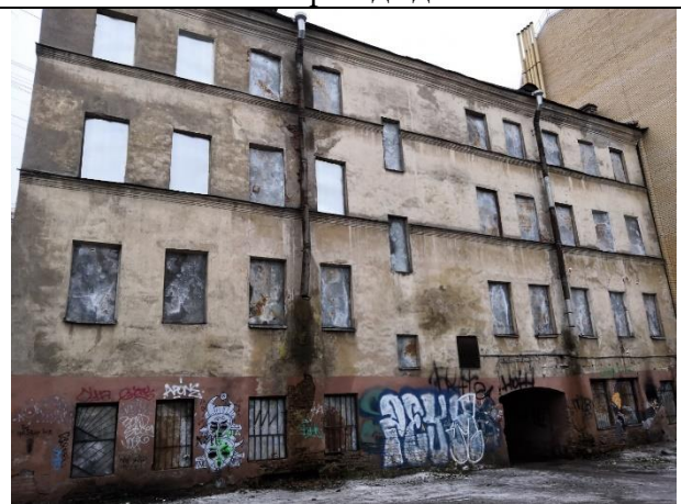
Фото 4 задний фасад здания
