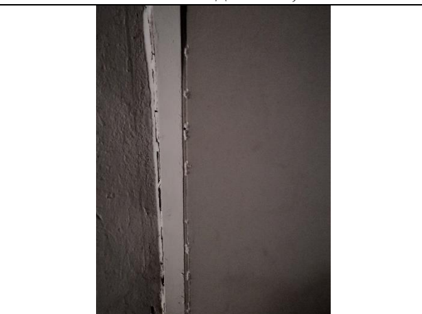
Фото 12 вход к кв. 2
