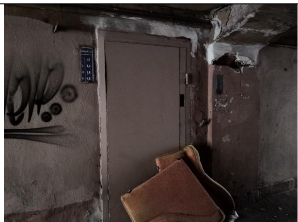
Фото 10 вход к кв. 1,3-8
