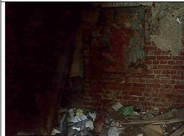
Фото 18 Состояние пом. 3Н
