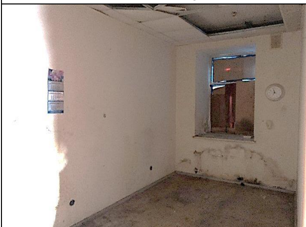
Фото 20 Внутреннее состояние ч.п. 6
