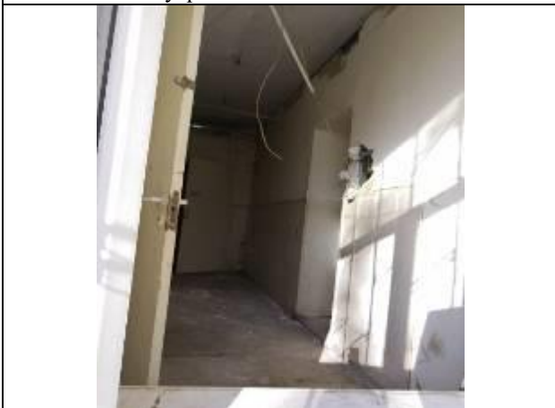
Фото 22 Внутреннее состояние ч.п. 1
