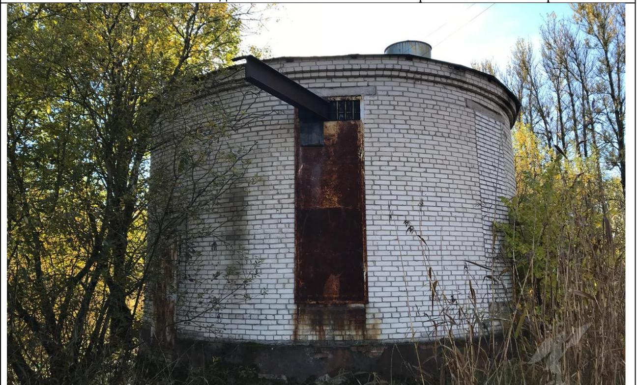
Фото 2. Оцениваемый объект недвижимости. Состояние стен. Проемы заложены кирпичом.
