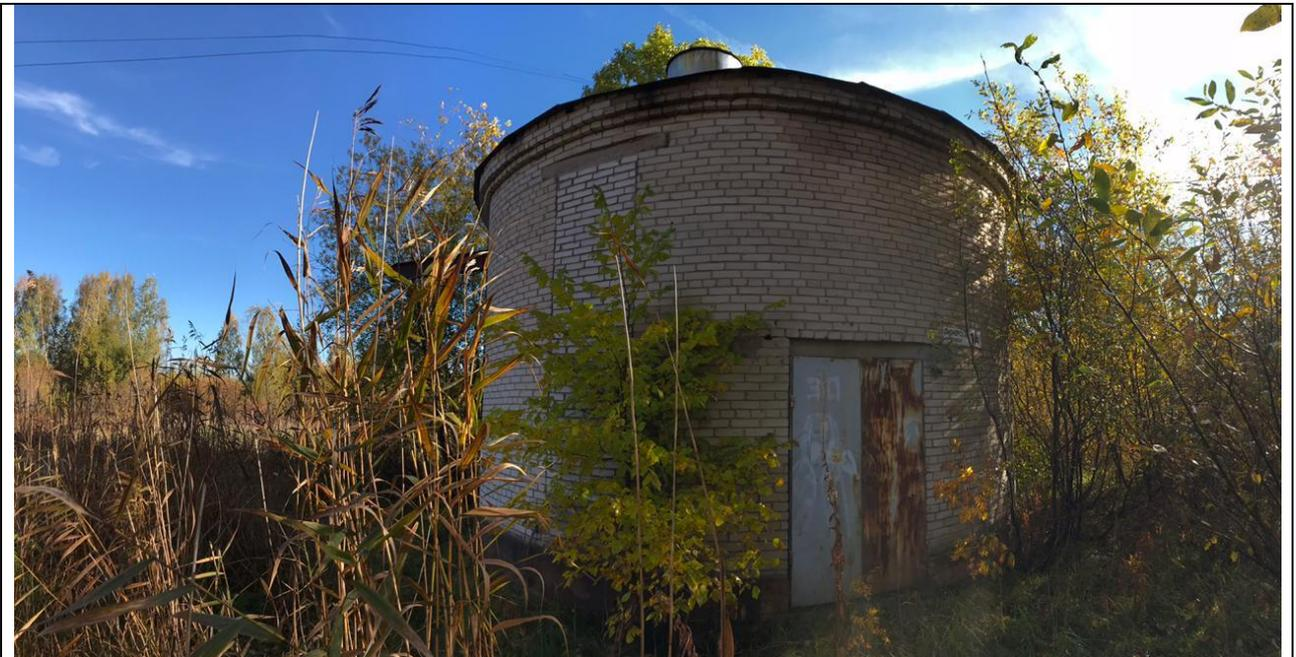
Фото 1. Оцениваемый объект недвижимости. Состояние стен. Проемы заложены кирпичом.
