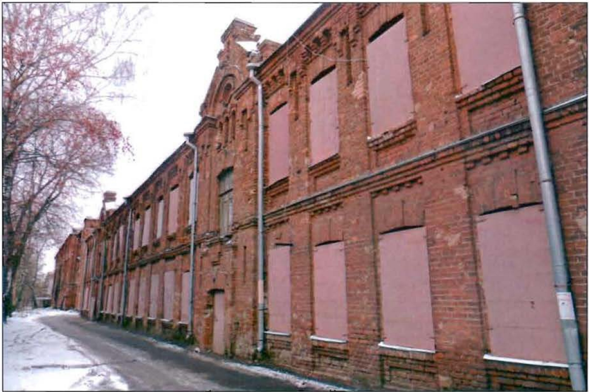
2. Общий вид с юго-востока.
